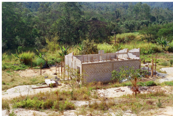
Figura 21 - Casa de farinha em construção em área comunitária.
