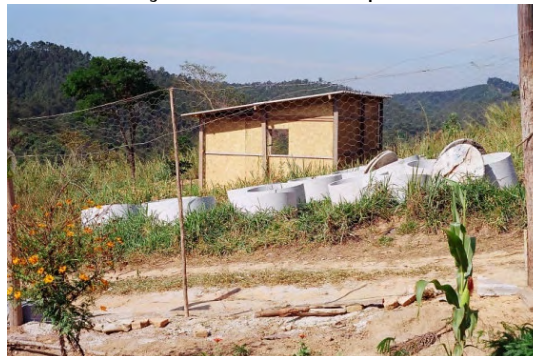
Figura 43 - Manilhas que serão utilizadas na construção das fossas sépticas.
