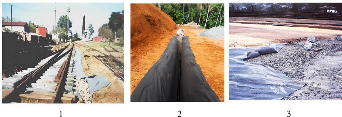
Figura 2.13: Aplicações de geotêxteis em obras de drenagem e/ou filtração: 1-Aplicação em pavimento ferroviário; 2- Aplicação em obras de terra; 3- Aplicação em áreas de esporte e lazer (Adaptado de BIDIM (2010); GEOSUL GEOSINTÉTICOS (2021) & GARDONI (2000)).
