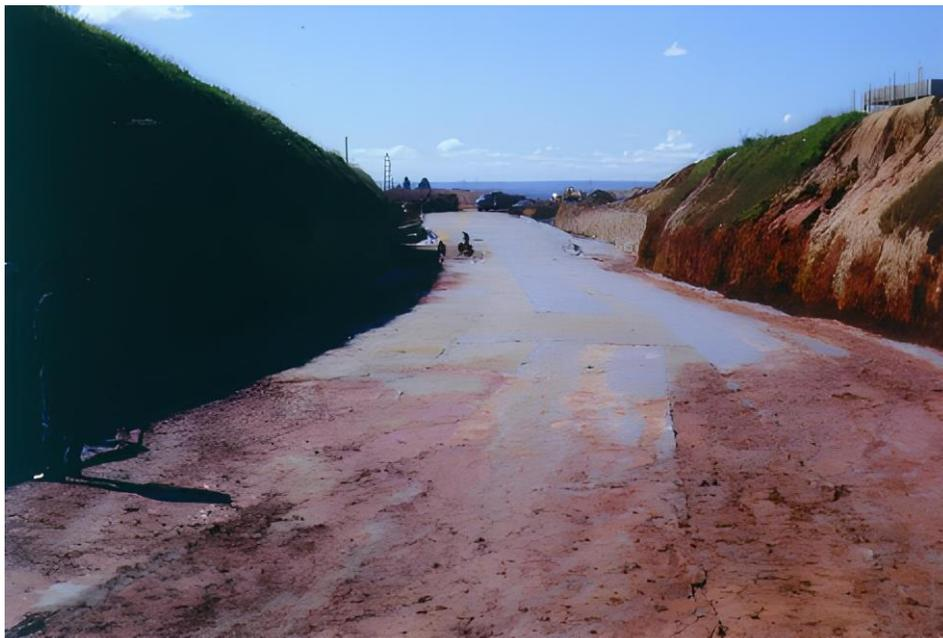
Figura 2.23: Corrida de lama sobre o geotêxtil (PALMEIRA, 2018).
