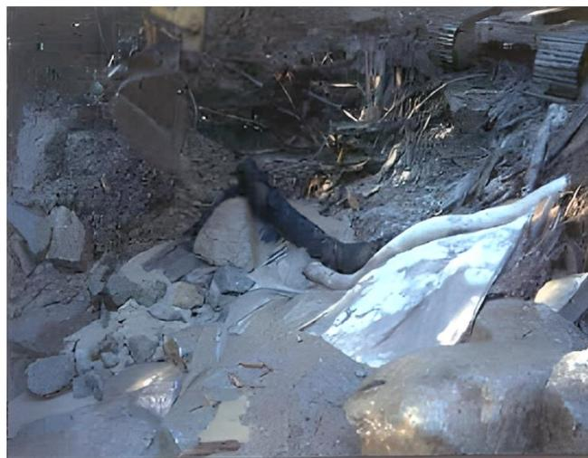
Figura 2.22 Instalação incorreta de geotêxtil em aterro (PALMEIRA).
