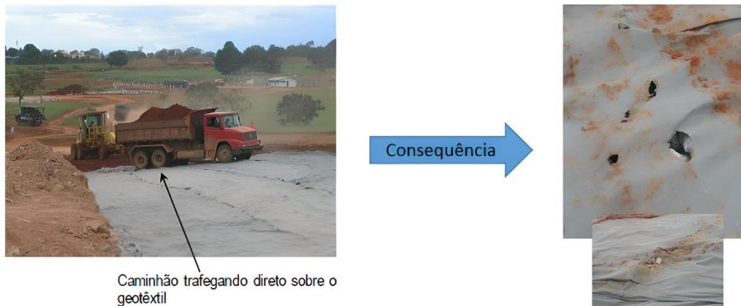
Figura 2.21: Tráfego de caminhão diretamente sobre o geotêxtil. (Adaptado de PALMEIRA, 2018).
