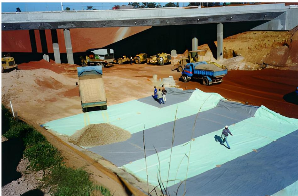
Figura 2.24: Instalação de diferentes tipos de geotêxtil em uma mesma camada de solo (PALMEIRA, 2018).
