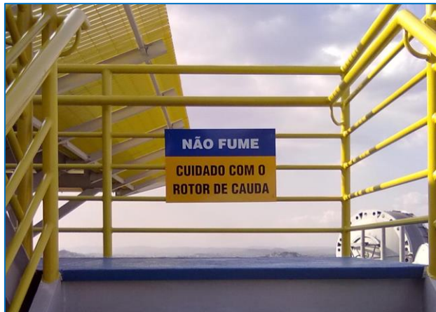
Figura 16 – Avisos de segurança em heliponto elevado. Foto: Acervo pessoal do autor
