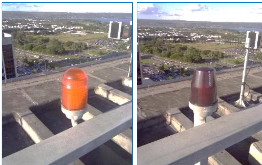
Figuras 83 e 84 – Uso simultâneo irregular de globo prismático em borosilicato padrão e filtro SN06
