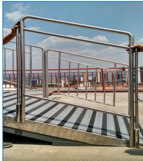
Figuras 58 e 59 – Complementação do guarda-corpo, fechando uma seção da direita e toda a lateral esquerda da rampa de acesso ao heliponto
