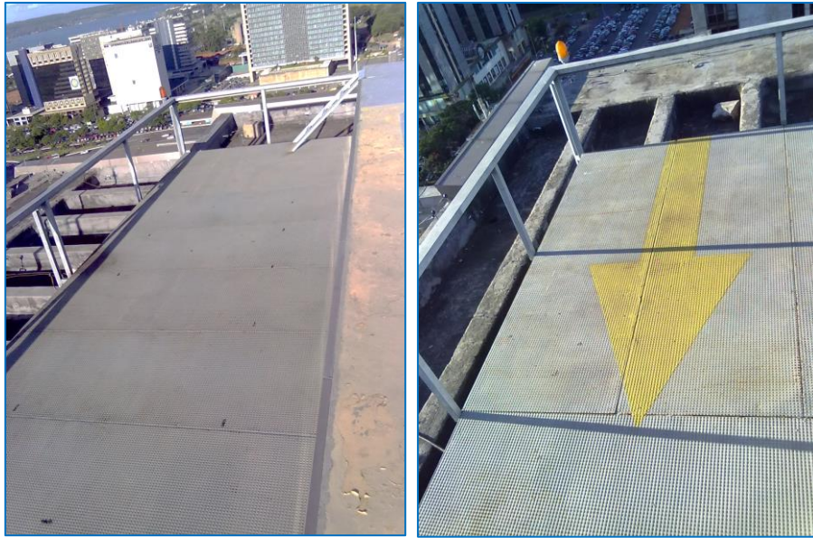
Figuras 75 e 76 – Uso extensivo de chapas de aço xadrez compondo a FATO
