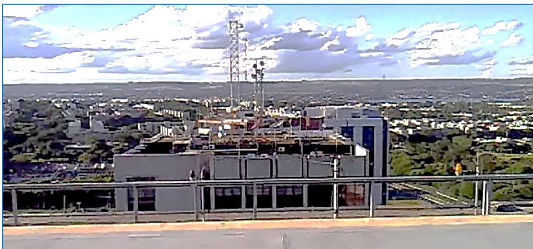
Figura 87 – Proximidade de edifício vizinho, mostrando as antenas e repetidoras de rádio, telefonia celular e internet instaladas em sua cobertura
