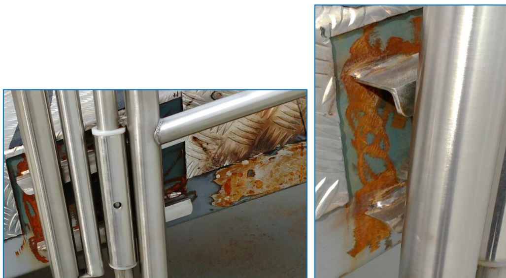
Figuras 56 e 57 – Pontos esmerilhados, lixados e/ou raspados e pontos de solda sem acabamento ou proteção
