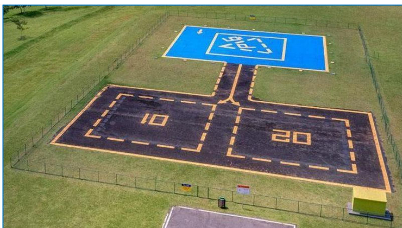
Figura 9 – Configuração de um heliponto padrão ao nível do solo com FATO, em azul, no formato retangular. Fonte: internet
