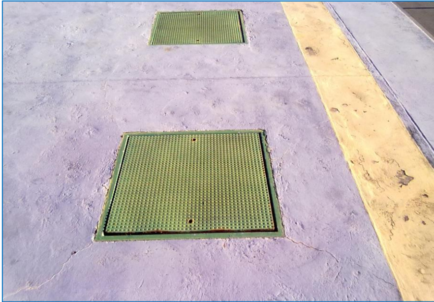
Figura 77 – Alçapões das caixas d’água localizados na TLOF
