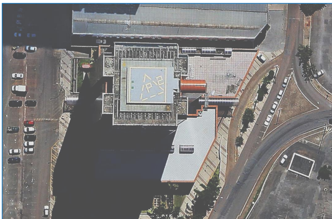
Figura 74 – Vista aérea da PDC em estrutura concreto/aço vistoriada. Imagem: Google Earth
