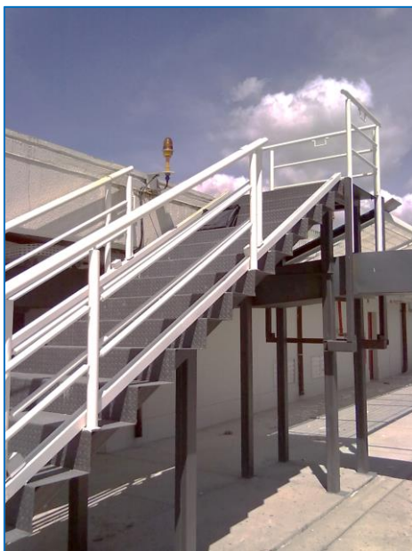
Figura 8 – Guarda-corpo escamoteável com uma das seções abaixada, obedecendo ao que orienta a legislação. Foto: Acervo pessoal do autor
