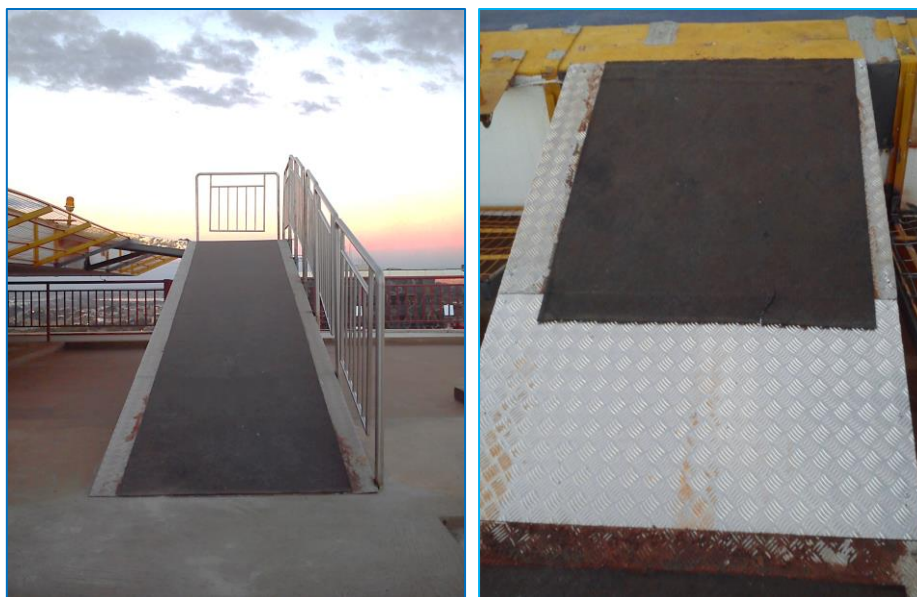
Figura 52 – Rampa de acesso ao heliponto - 1ª seção com destaque para a manta emborrachada instalada
