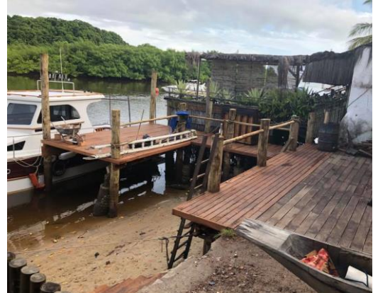
Figura 6 - Ocupação ilegal na beira do rio
