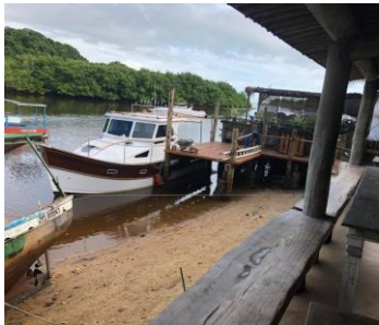
Figura 36 - Deck ilegal na beira do rio
