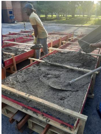
(a) Lançamento do concreto
