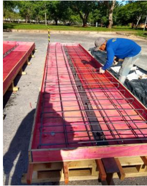
(a) Montagem da armadura
