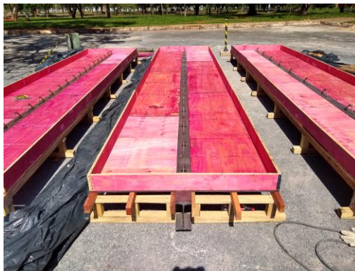
(c) Fixação dos madeirites
