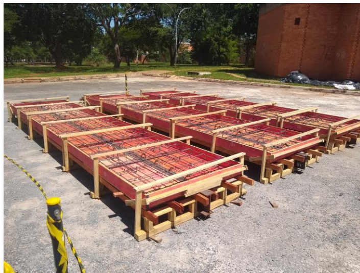
(e) Fôrmas com travamento
