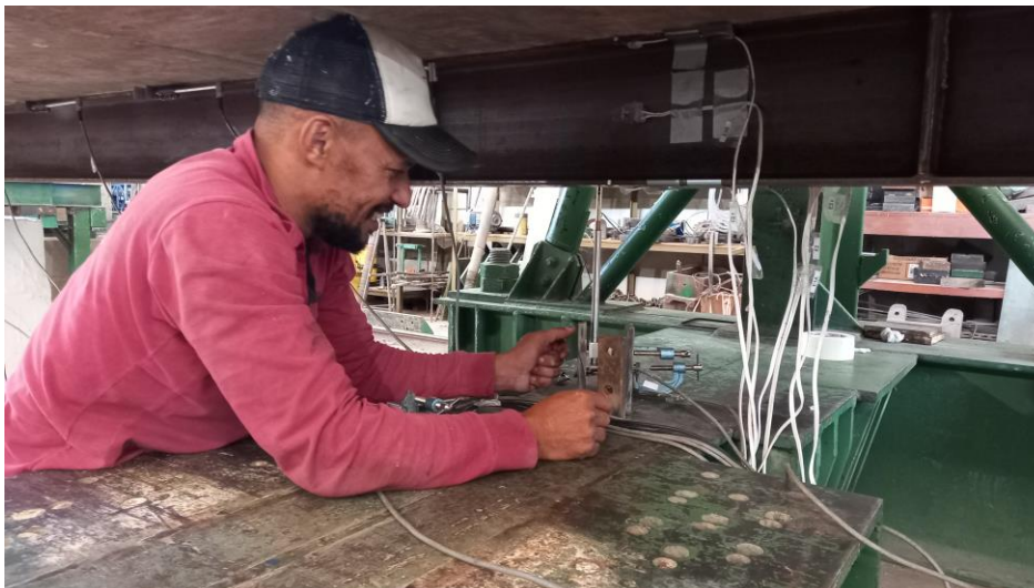
Figura 5.22- LVDT para medida do deslocamento vertical no meio do vão.
