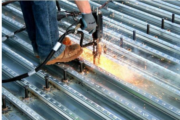
Figura 1.1- Stud bolt sendo aplicado em lajes com fôrma de aço incorporado (< http://www.globalcenter.com.br >).
