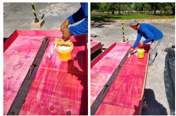
(d) Aplicação dos desmoldante
