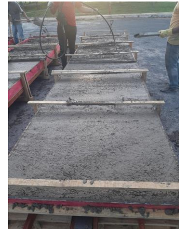
(c) Adensamento do concreto
