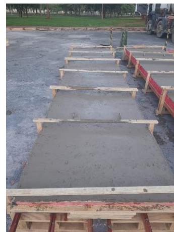
(e) Modelo após concretagem
