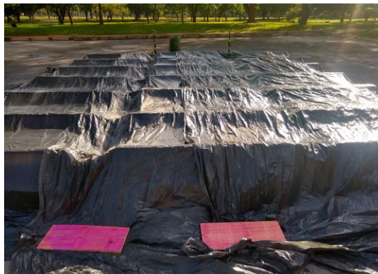
(c) Aplicação da lona plástica
