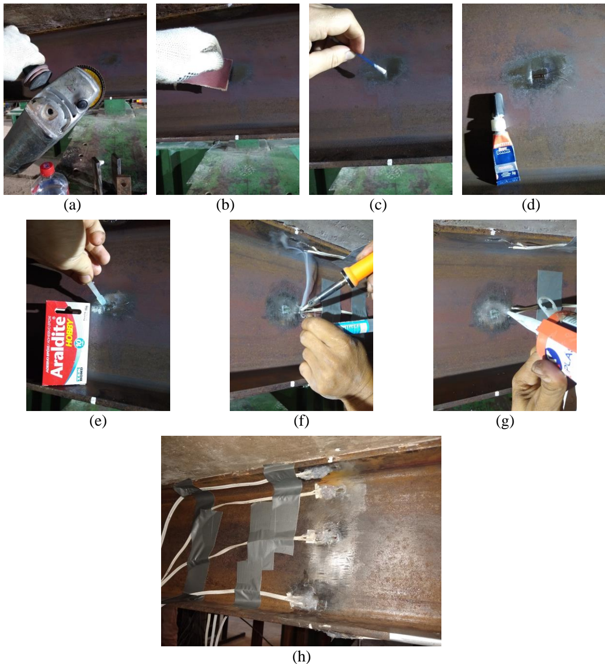
Figura 5.23- Procedimentos para aplicação dos extensômetros no perfil de aço.
