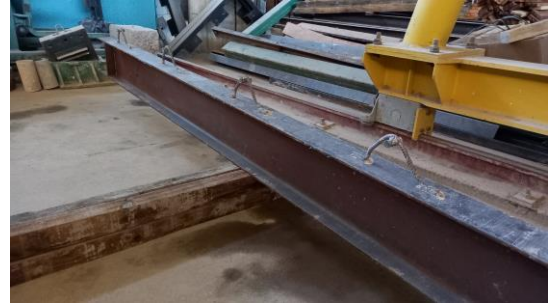
(a) CTs deformados no perfil de aço
