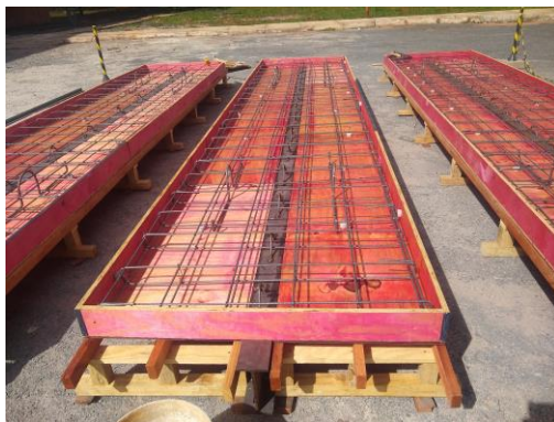
(c) Armadura do modelo finalizada
