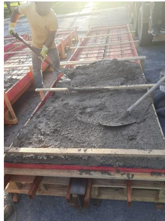
(b) Distribuição do concreto no modelo
