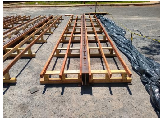
(b) Fixação dos caibros
