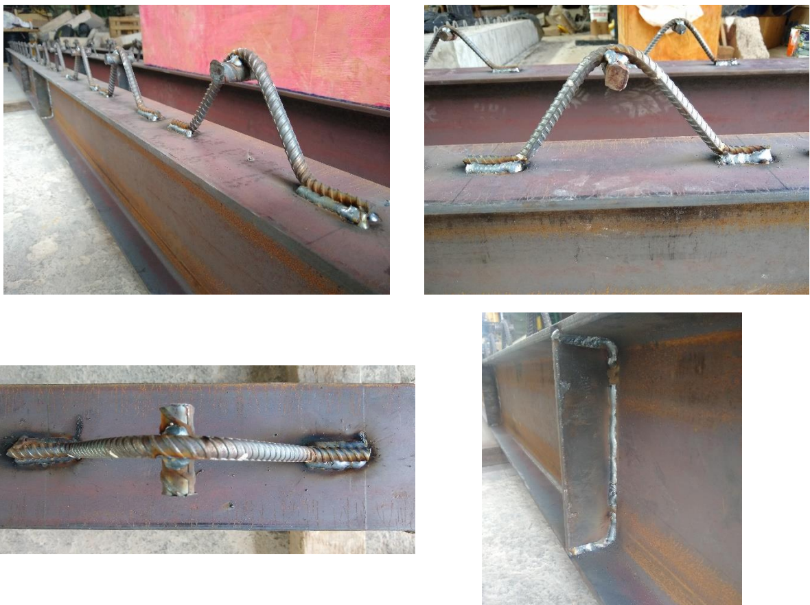
Figura 5.5- Solda de aplicação do CT e enrijecedor no perfil de aço.
