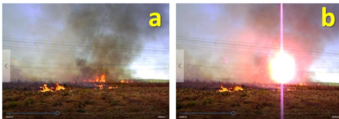
Figura 6 – Dinâmica da ocorrência de um desligamento forçado em dois momentos: (a) incêndio florestal ocorrendo na vegetação seca localizada na faixa de segurança e coluna de fumaça e fuligem sendo deslocada pelo vento em direção aos cabos condutores; (b) curto-circuito na linha de transmissão devido à presença da fumaça e fuligem (ANEEL, 2016b)
