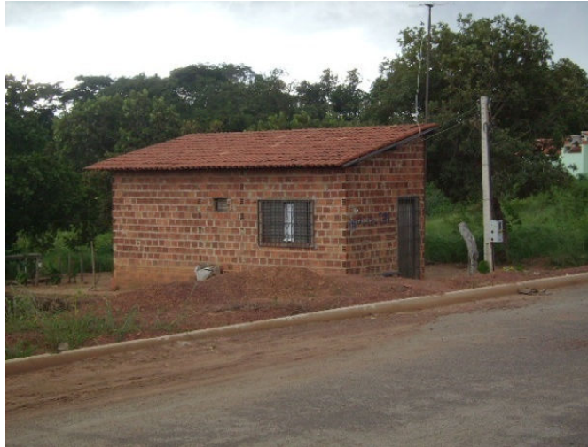
Figura 3.5 Casa doada à população nos Aurenys, entre 1990 e 1998.
