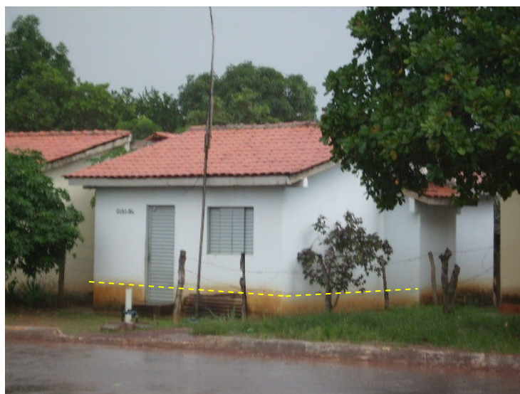
Figura 3.17 Casa-padrão do Santa Bárbara, mostrando marca de inundação.
