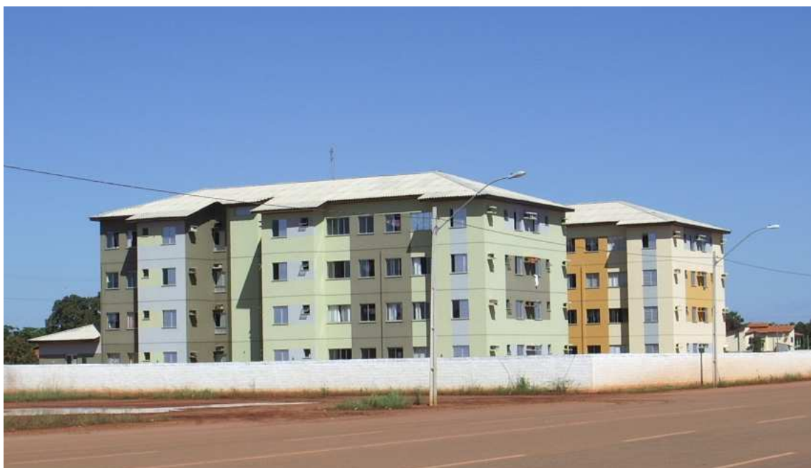
Foto 16: Vista do Residencial Rio Tocantins, construído através do Programa de Arrendamento Residencial – PAR na quadra ARSO 42, para famílias com renda até 4 S.M. (AMARAL, 2008).
