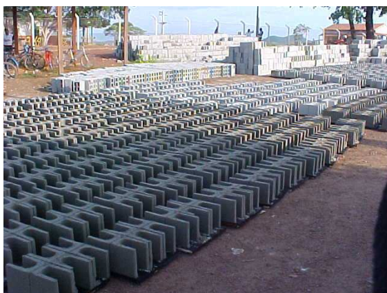
Foto 27: Estoque de blocos produzidos para abastecer as equipes de construção de unidades habitacionais (AMARAL, 2004).
