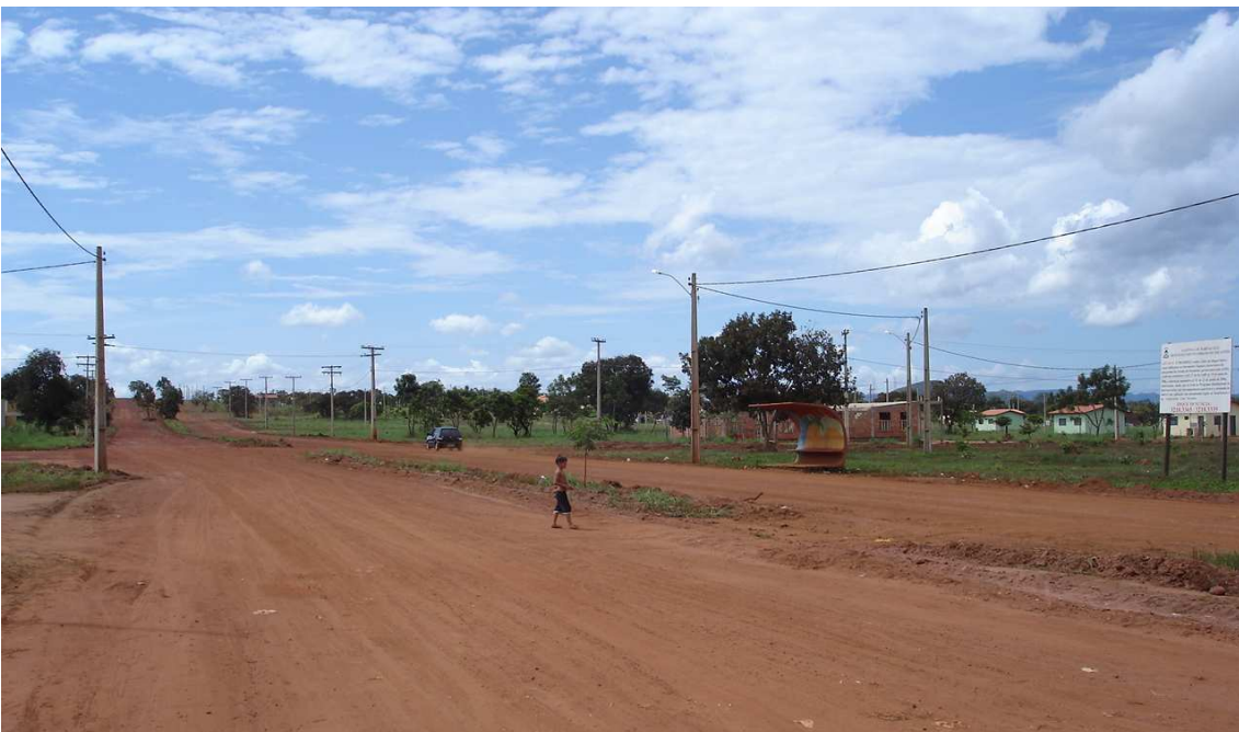
Foto 2: Vista parcial do loteamento Jardim Taquari. (Fonte: Amaral, 2007)
