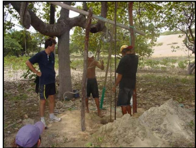
**Figura 3.44** - Técnica manual empregada na construção de poços para captação de água subterrânea no Aquífero Dunas.
