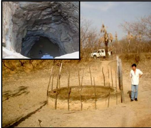
**Figura 3.41** - Cacimba escavada no embasamento cristalino para captação de água subterrânea próxima à BR-222. No canto superior esquerdo, detalhe da parede interna e do nível d'água.
