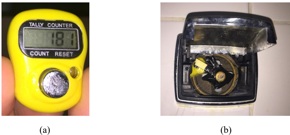
Figura 163: Instalação de mini contadores (a) junto a válvula de descarga (b).
