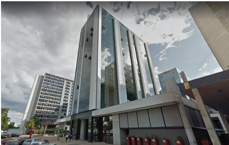
Figura 108. Edificação de escritórios selecionada para estudo de caso.
