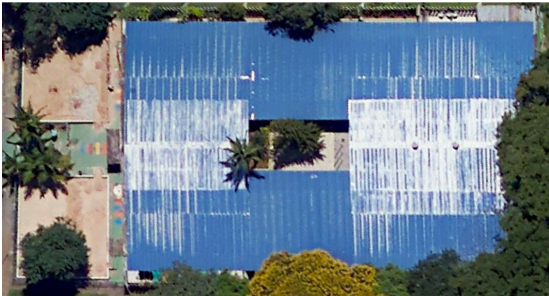
Figura 120. Edificação de Ensino Fundamental I selecionada para estudo de caso (EC 415N).
