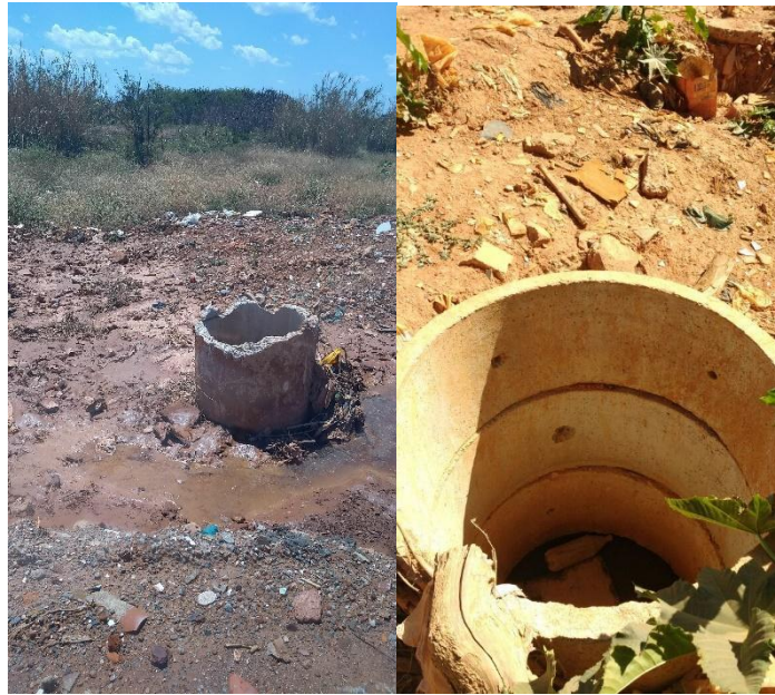
Figura 19 - Estado de conservação dos drenos de lixiviado dentro da área do ACJC.
