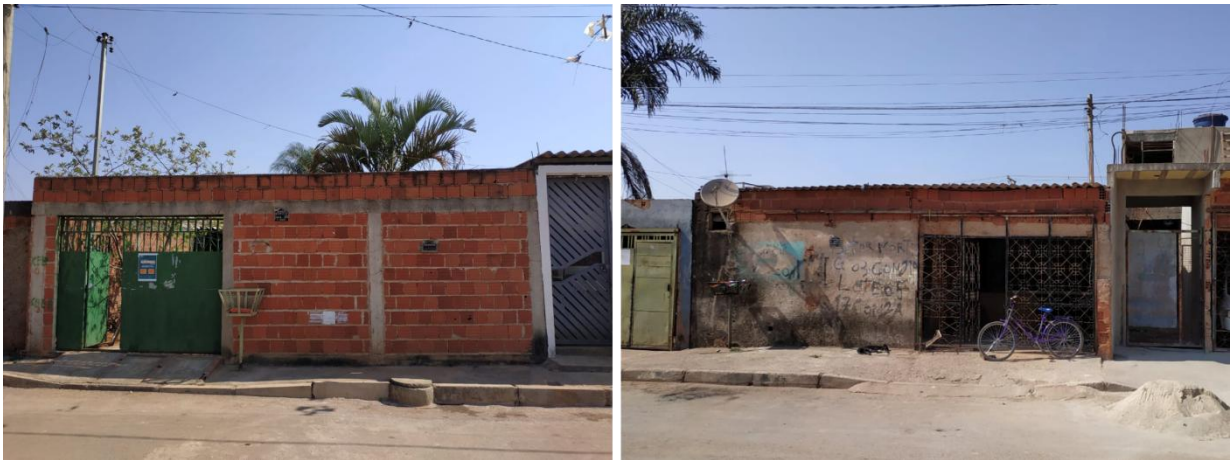
Figura 4: Muro como elemento de interface entre âmbito doméstico e público. Edificação recuada (esquerda) e alinhada ao limite do lote (direita)
