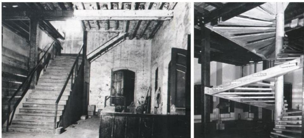
Figura 16 - Escadas velha e nova. Fonte: Ferraz, 1993, p. 157 e 158.
