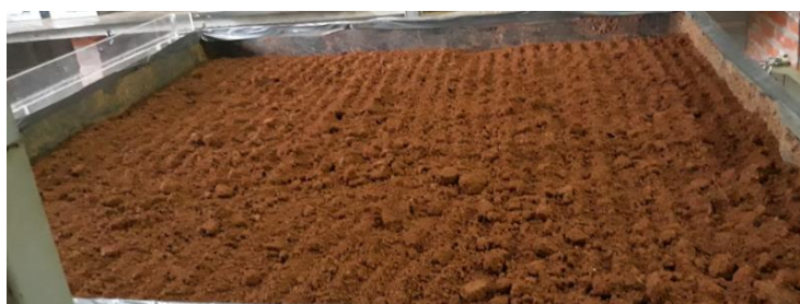
Figura 3.40 - Detalhe da escarificação entre as camadas de solo
