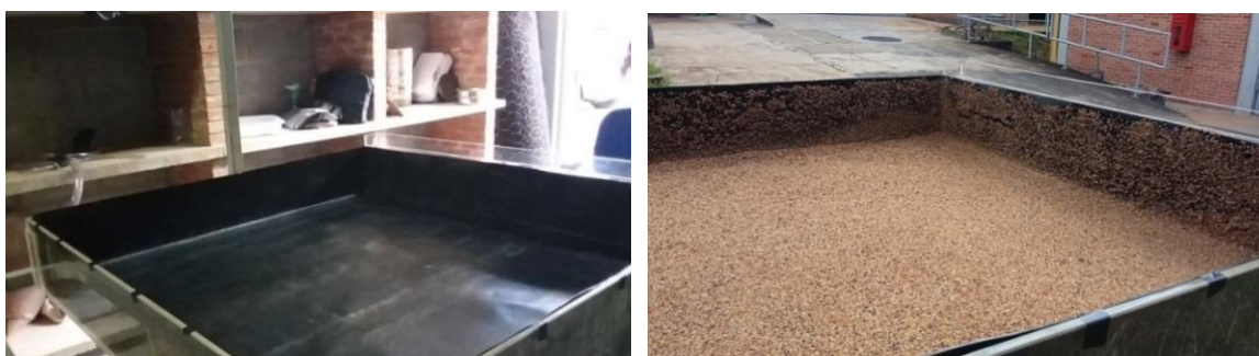
Figura 3.37 - Colocação da geomembrana e colagem de areia no fundo e lateral da caixa
