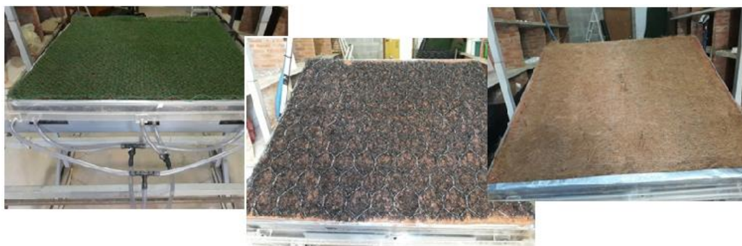
Figura 3.41 - Detalhe da instalação das geomantas na superfície do solo (Geomantas 1, 2 e 3)
