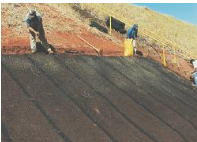
Figura 2.6 - Talude com aplicação de geomanta. Fonte: Maccaferri do Brasil (2013)
