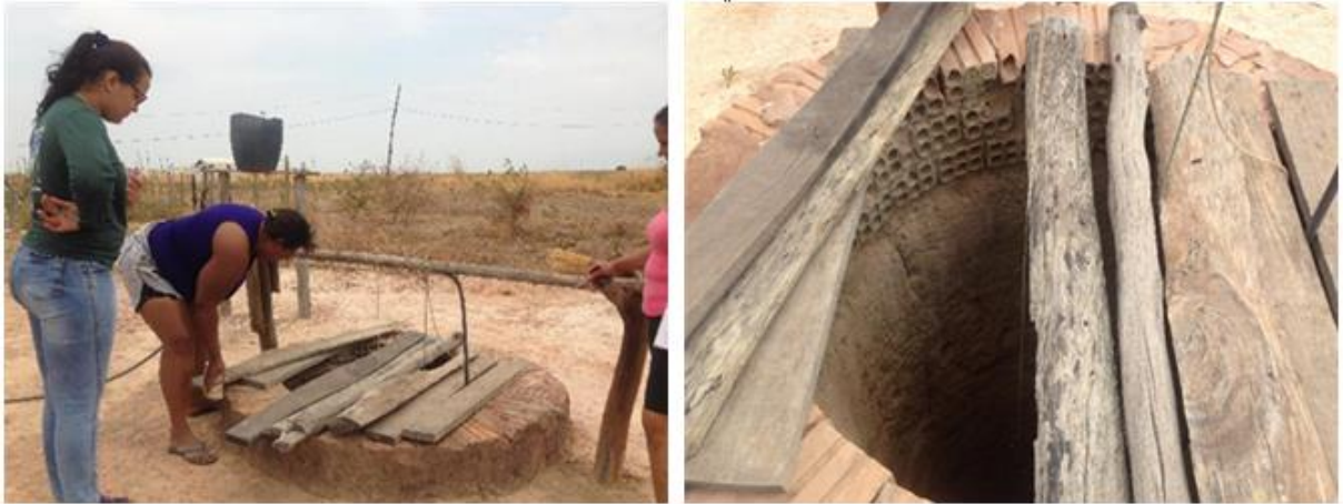
Figura 17 - Cisternas escavadas e construídas pelas famílias. Fonte: Acervo pessoal.
