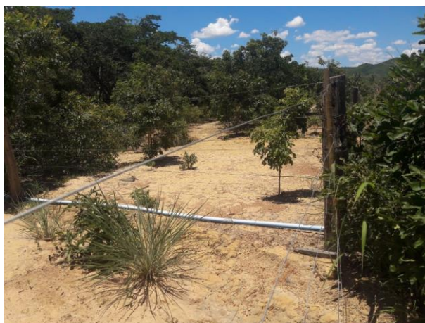
Figura 33 - Sistema de distribuição de água. Fonte: Acervo pessoal, janeiro de 2019.
