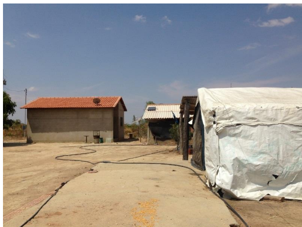
Figura 19 - Casa de alvenaria e barraco de lona. Fonte: Acervo pessoal.
