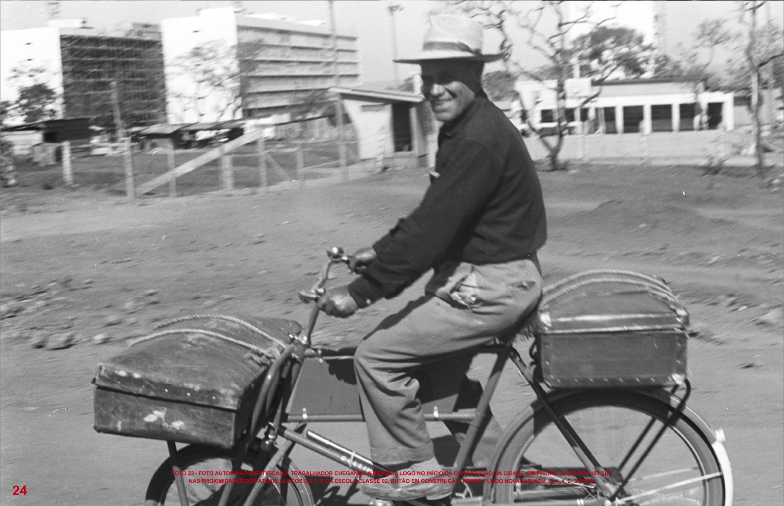
FOTO 22 - FOTO MARIO FONTENELLE. 1962-1963. TRABALHADORES DA CONSTRUÇÃO CIVIL NA HORA DO CAFÉ DA MANHÃ EM FRENTE AO REFEITÓRIO DO CANTEIRO DO INSTITUTO DE APOIAMENTO E PENSÕES DOS BANCÁRIOS. FONTE: ANPOF, FUNDO NOVALAT, NOV_D_4_4_C_3 (226)
