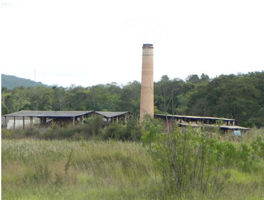
FIGURA 8 - Chaminé da Cerâmica Arte, ainda existente em São Sebastião. A Cerâmica foi recentemente desativada. Foto: Guilherme França. 18/05/2012.
