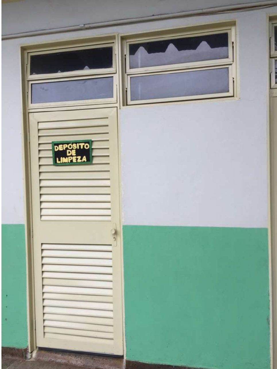
FOTOGRAFIA 14– Espaço de guarda da documentação histórica da EC Cerâmica da Benção. Vista externa. Novembro / 2018. Foto: Guilherme França.
