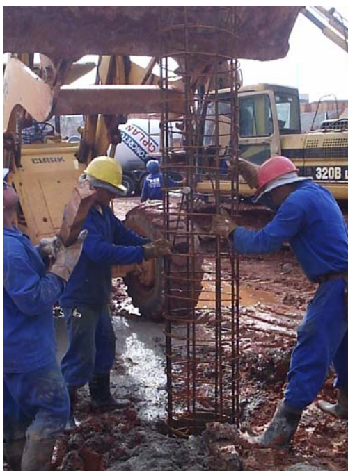
Figura 4.12 – Dificuldade na instalação da armação
