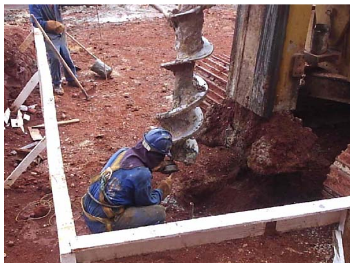
Figura 2.3 – Colocação da tampa metálica provisória
