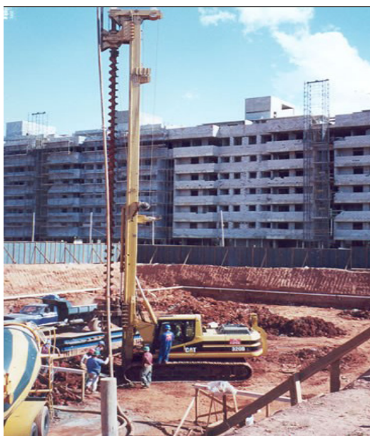
Figura 2.9 – Equipamento para perfuração de estacas hélice contínua
