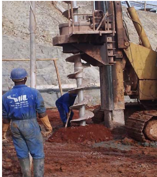
Figura 2.2 – Etapa de perfuração
