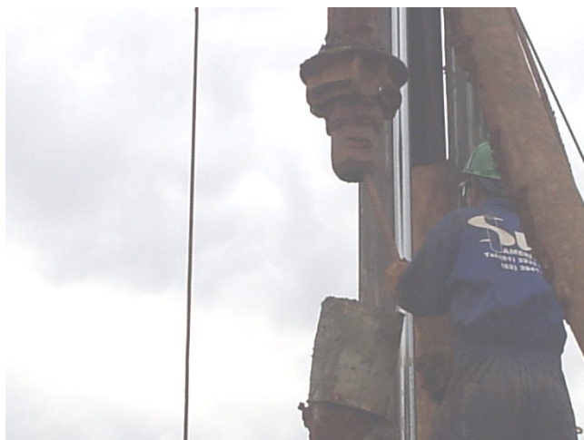
Figura 4.4 – Entupimento de hélice
