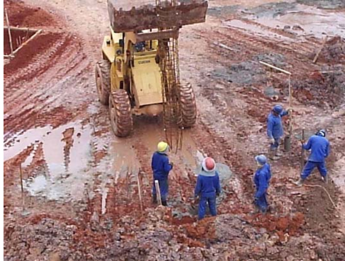
Figura 2.6 – Utilização de pá carregadeira na instalação da armadura
