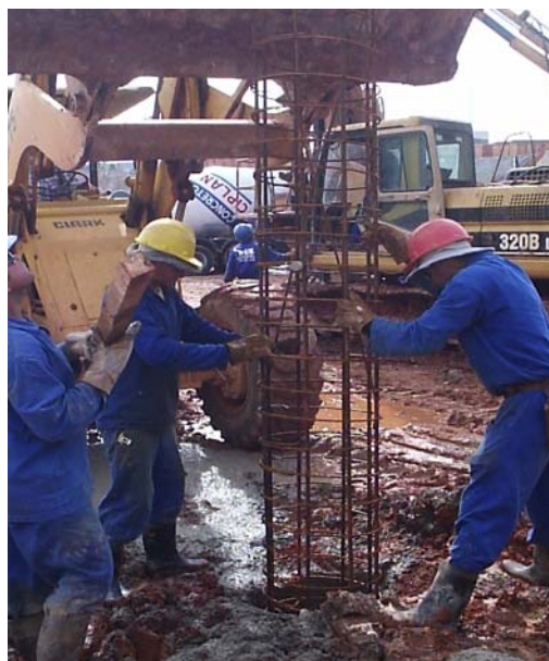
Figura 2.7 – Instalação manual da armadura
