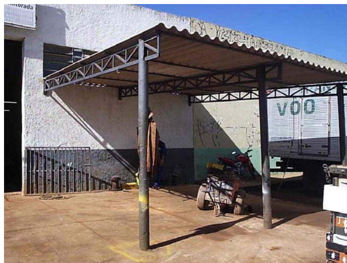
Figura 4.17 – Cobertura construída no galpão da empresa
