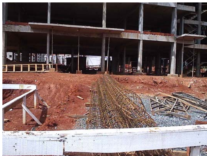
Figura 4.11 – Armação de estacas hélice sem espaçadores
