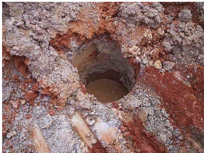
Figura 4.8 – Estaca não concluída
