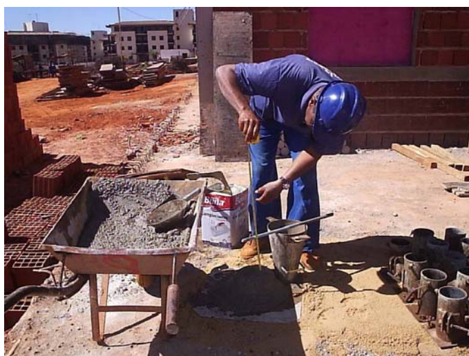
Figura 4.23 – Acompanhamento do controle tecnológico do concreto.
