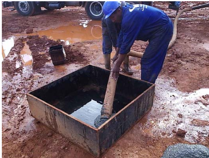
Figura 4.22 – Realização do ensaio para calibração da bomba de concreto
