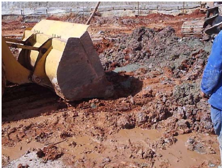
Figura 2.5 – Retirada do solo para fora da área de trabalho
