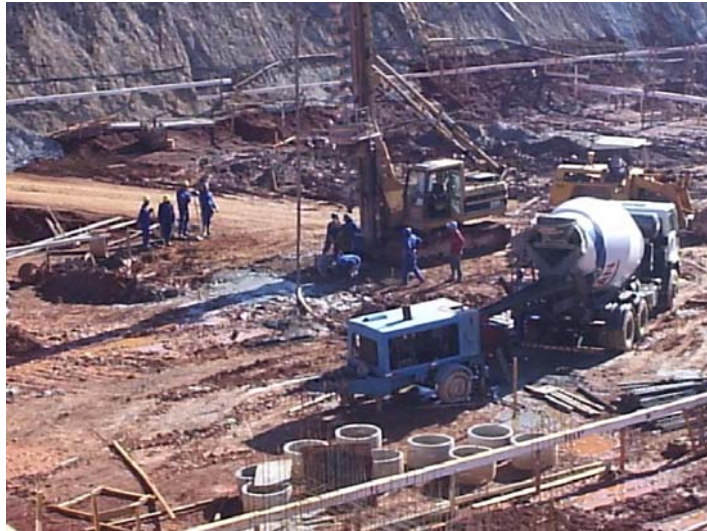
Figura 4.7 – Paralisação dos serviços para manutenção da perfuratriz
