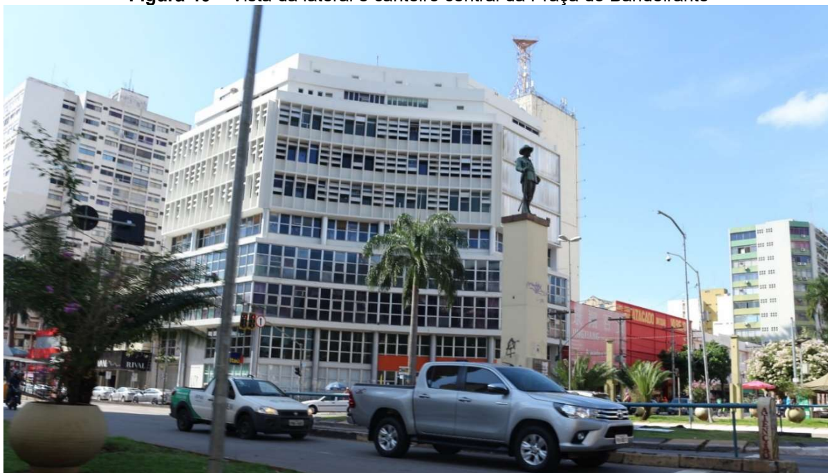
Figura 40 – Vista da lateral e canteiro central da Praça do Bandeirante
