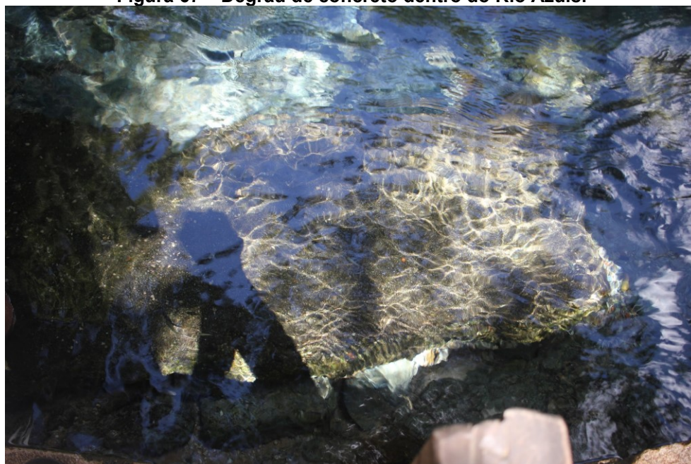
Figura 67 – Degrau de concreto dentro do Rio Azuis.
