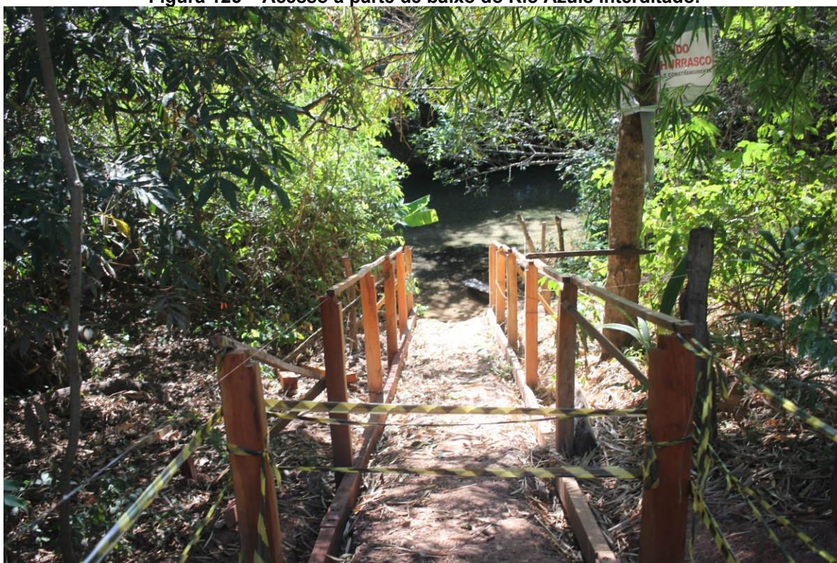
Figura 125 – Acesso à parte de baixo do Rio Azuis interditado.
