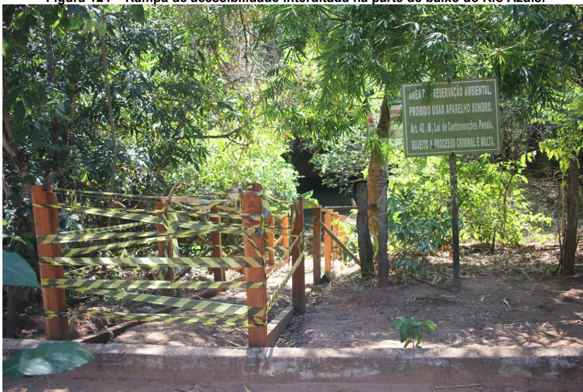
Figura 124 – Rampa de acessibilidade interditada na parte de baixo do Rio Azuis.
