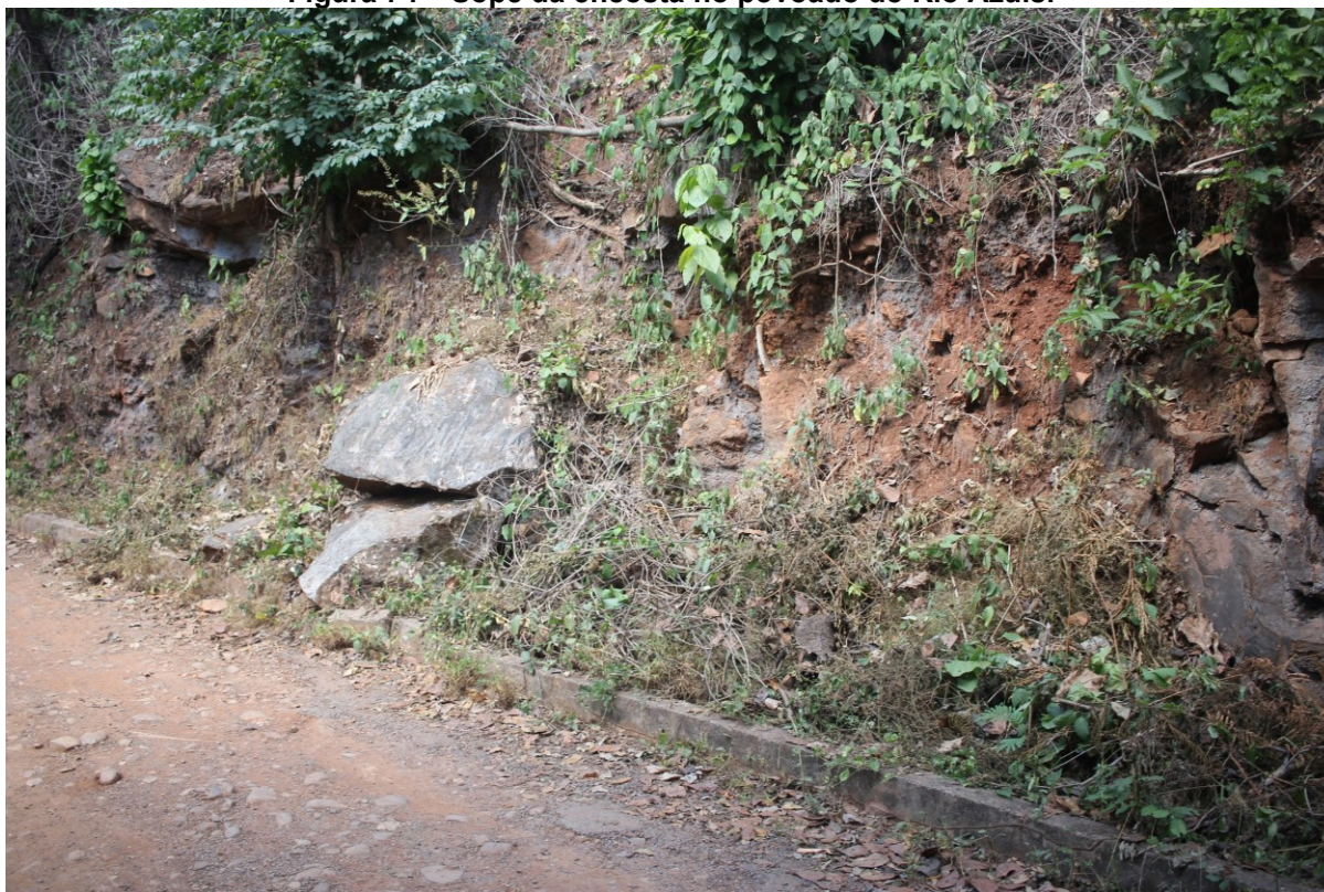
Figura 74 – Sopé da encosta no povoado do Rio Azuis.
