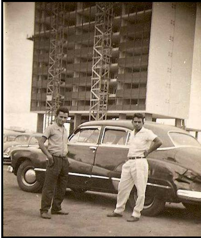
Ilustração 228: Prédio do Banco do Brasil em construção no Setor Bancário Sul. Seu Valdir (à direita) e seu amigo Geraldo. O carro estava no estacionamento e não pertencia a nenhum dos dois.
