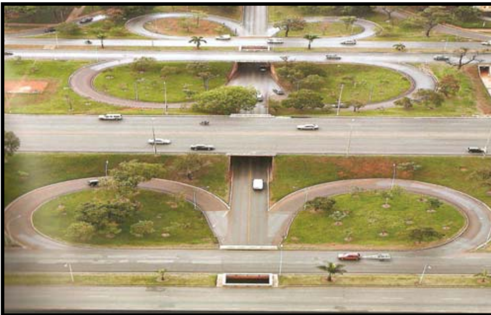
Ilustração 29: Eixão, via expressa com 15 km de extensão, seis faixas de rolamento e uma central de escape (CORREIO BRAZILIENSE, 2007, p. 19).
