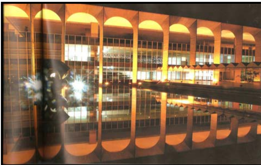
Ilustração 33: A fachada do Palácio do Itamaraty tem volume envidraçado e arcos em concreto. Um grande espelho d'água o aproxima do passeio público com um jardim de plantas aquáticas tropicais criado por Burle Marx (CORREIO BRAZILIENSE, 2007, p. 61).
