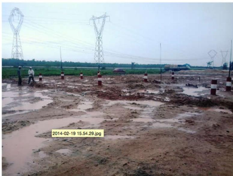
Figura 3.12 - Instrumentação instalada e protegida (DNIT, 2014a).
