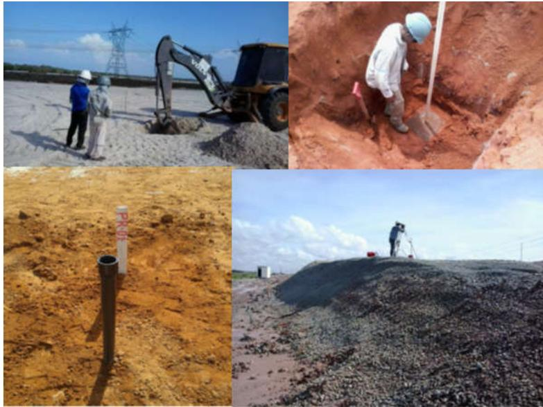
Figura 3.20 - Etapas da PR nas obras da BR-135/MA: a) e b) instalação, c) tubo de proteção, d) leitura (DNIT, 2015).
