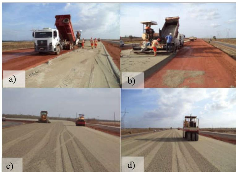
Figura 3.15 - a) e b) Aplicação da camada de base granular BGS, c) e d) nivelamento e compactação da camada de base granular BGS (DNIT, 2014a).
