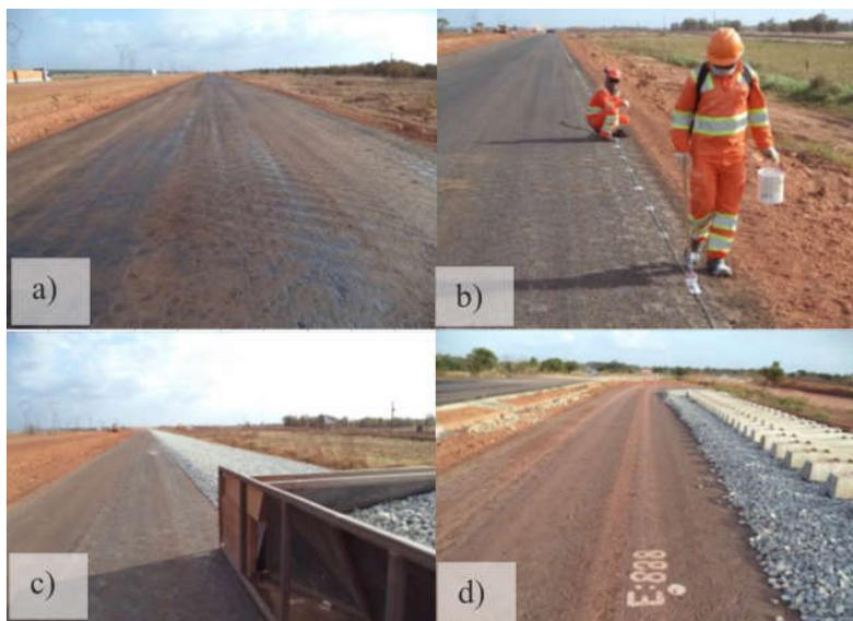
Figura 3.17 – Ferrovia: a) camada de sublastro imprimada e liberada para aplicação do lastro de agregados, b) marcação para aplicação do lastro de agregados, c) aplicação do lastro de agregados, para assentamento dos dormentes e d) aplicação dos dormentes de concreto (DNIT, 2014a).
