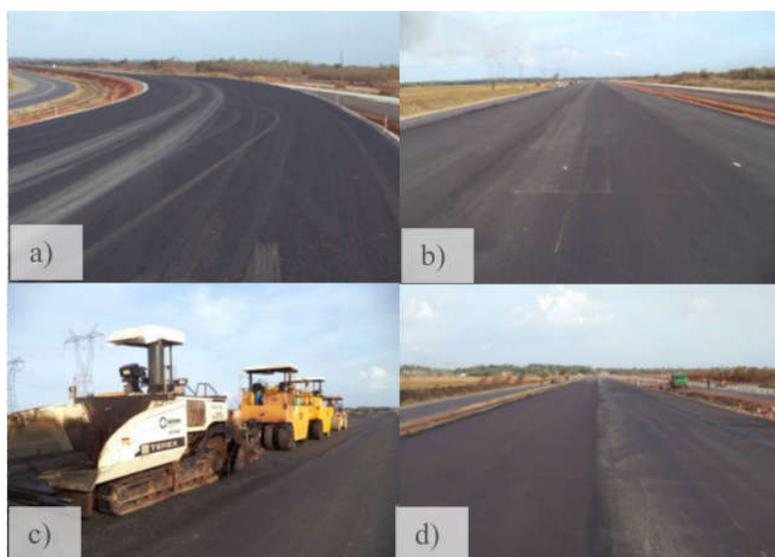
Figura 3.16 - a) Camada de base granular BGS imprimada, b) primeira camada de CBUQ, c) e d) segunda camada de CBUQ (DNIT, 2014a).
