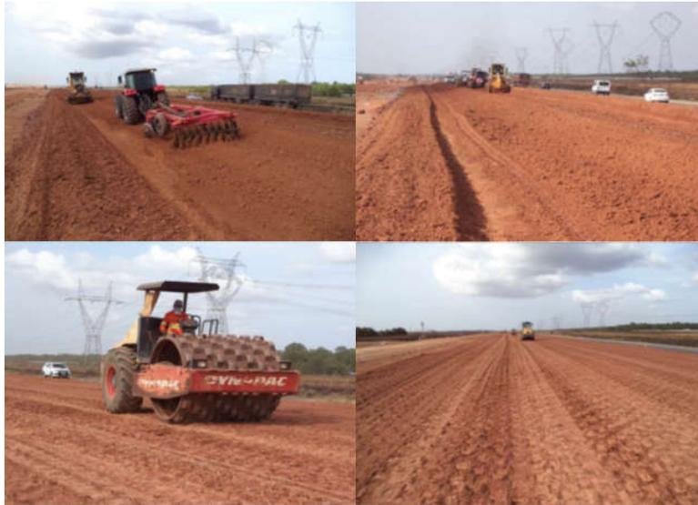
Figura 3.14 - Tratamento e compactação da segunda camada de aterro (DNIT, 2014a).
