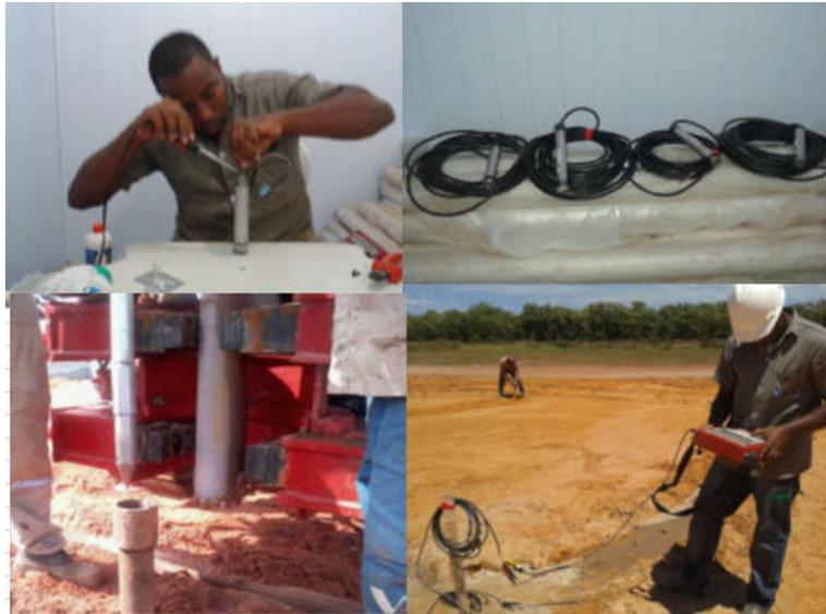
Figura 3.21 - a) Soldagem dos cabos dos piezômetros de corda vibrante, b) PZ com cabos já soldados, c) instalação de PZ, c) leitura da frequência dos PZ (DNIT, 2015).
