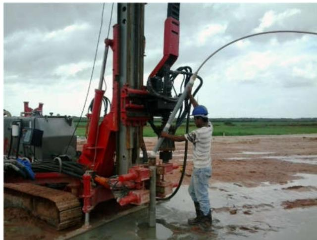
Figura 3.24 - Pré-furo para instalação de PZc (DNIT, 2015).
