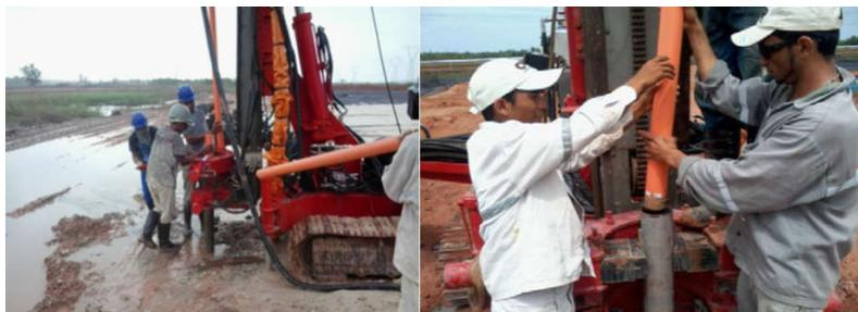
Figura 3.29 - Instalação de IN (DNIT, 2015).
