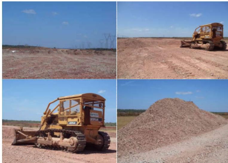
Figura 3.9 - Em andamento raspagem e remoção da camada de forro de agregados (DNIT, 2014a).
