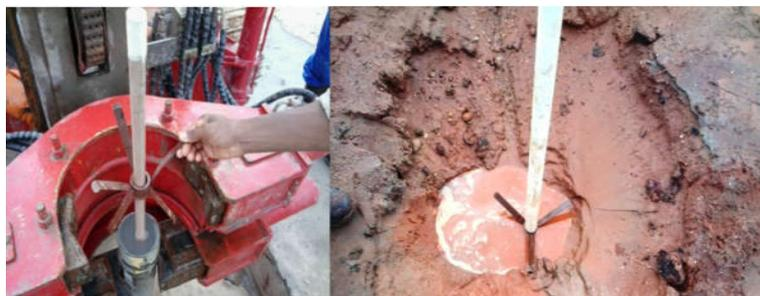
Figura 3.26 - Instalação de AM-V (DNIT, 2015).
