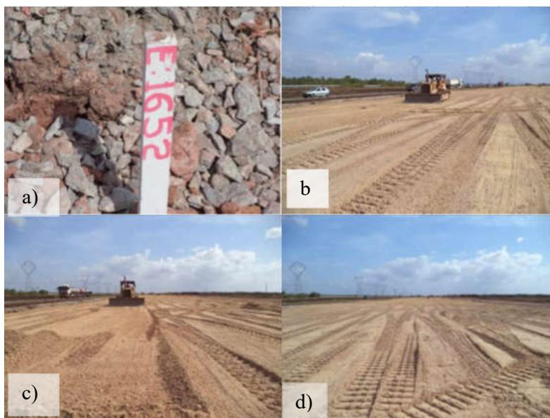
Figura 3.13 - a) Indicação da Estaca 1652, b), c) e d) aplicação da camada drenante de areia (DNIT, 2014a).
