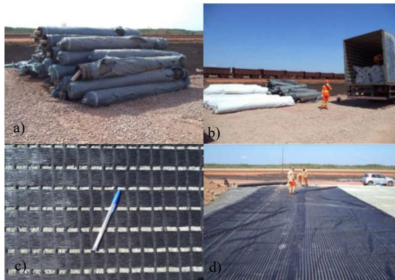
Figura 3.11 - a) Depósito de geogrelha, b) descarga de novos lotes do geossintético, c) e d) aplicação da geogrelha (DNIT, 2014a).
