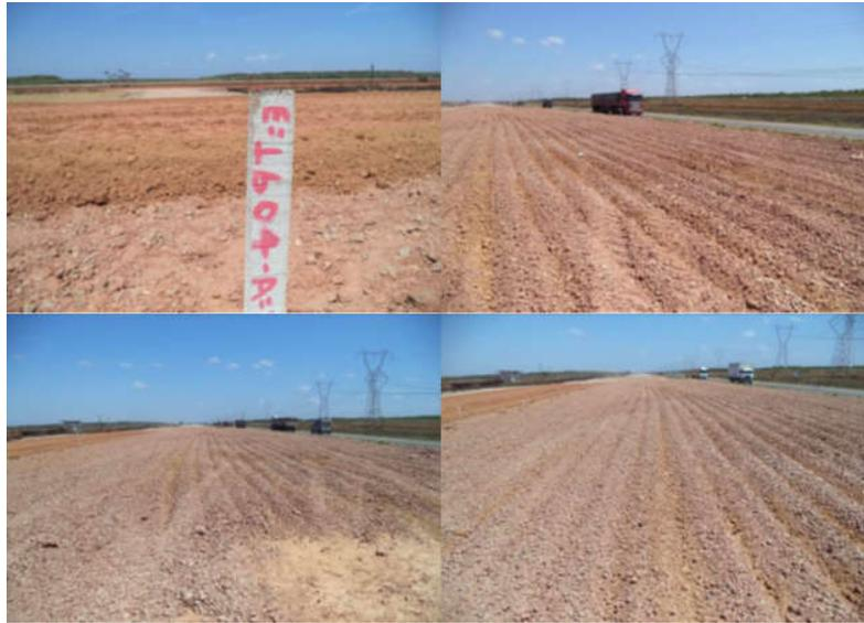
Figura 3.10 - Tratamento da camada de base material proveniente do forro de agregados oriundo da raspagem do suporte dos equipamentos de execução das colunas de brita (DNIT, 2014a).
