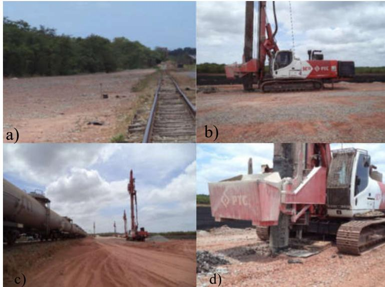
Figura 3.8 - (a) Estaca 1240+00 início do segmento com solução de colunas de brita, encaixe com a via férrea; (b) e (c) execução de colunas de brita; (d) colunas de brita finalizadas (DNIT, 2014b).
