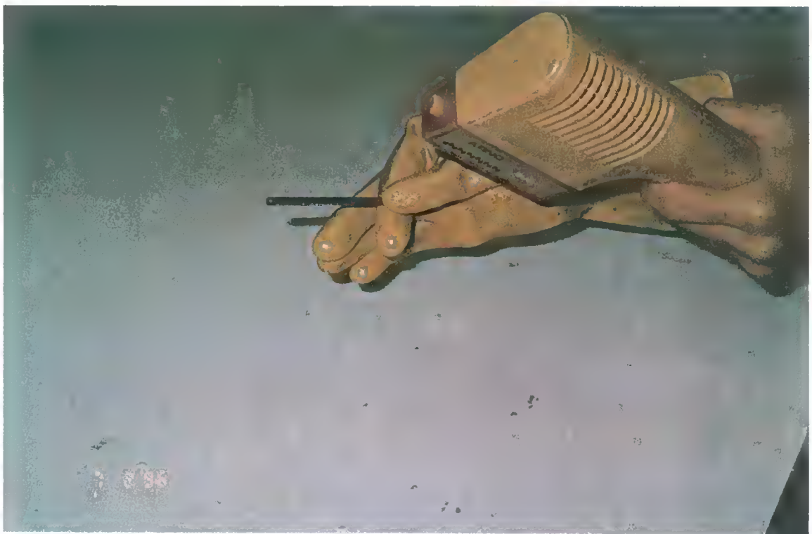
Foto 3.4- Secagem das barras com jato de ar quente.
