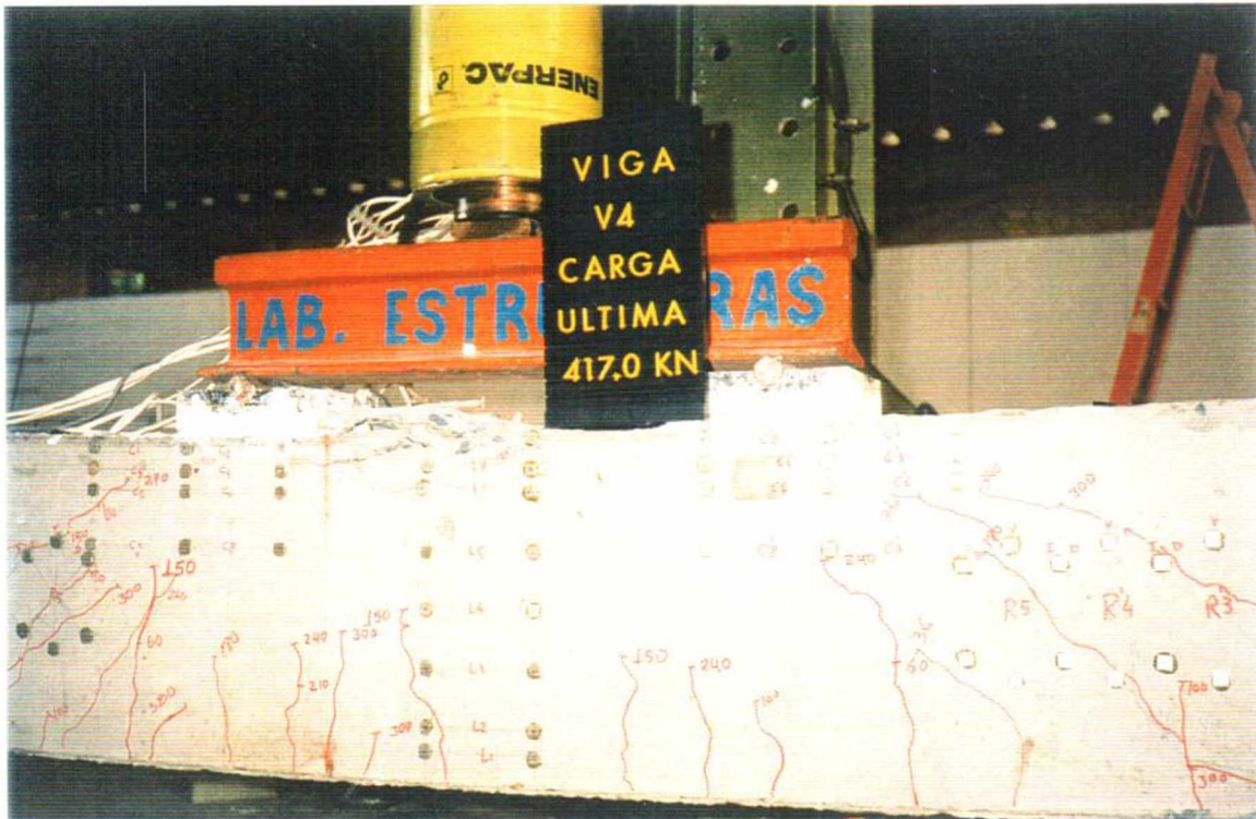
Foto 4.19 - Fissuração da viga V4 para a carga última
