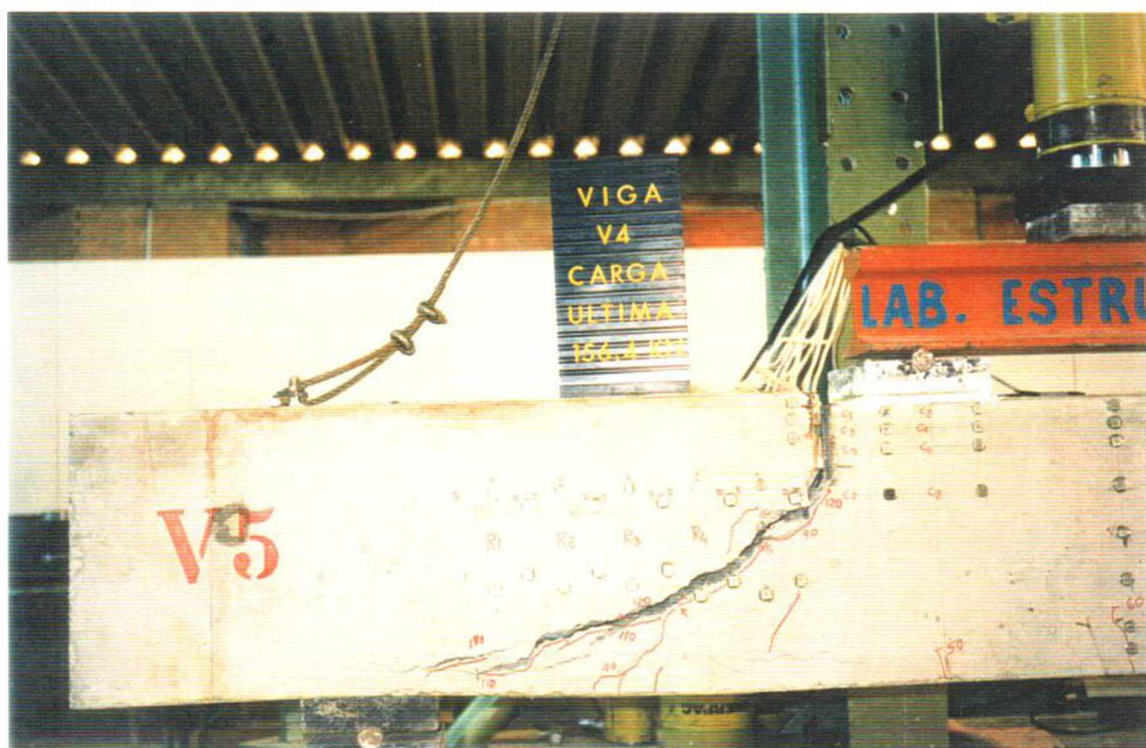
Foto 4.20 - Fissuração da viga V5 para a carga última
