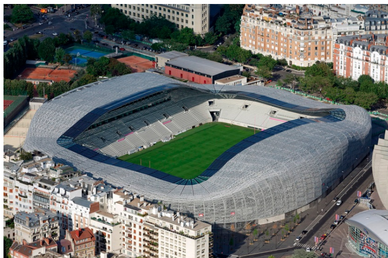
Figura 2.12: Estádio Jean Bouin, Paris; fachada e cobertura em CUAD. (Ricciotti 2007).
