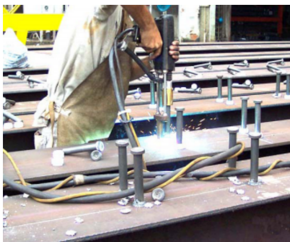
Figura 2.7: Soldagem por eletrofusão para conectores tipo pino com cabeça. (Kotinda 2006)
