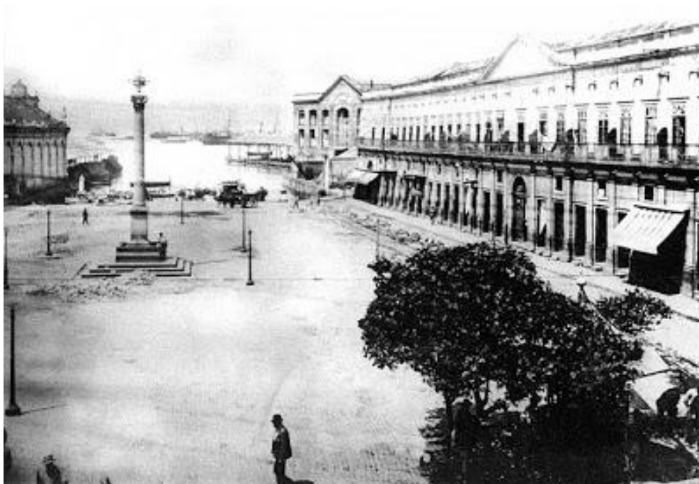
Figura 8 Obelisco comemorativo ao desembarque da Imperatriz Teresina Cristina em 1904. Inicialmente um chafariz com 4 bicas na imagem já se encontra bastante alterado, sem as bicas e o tanque que o compunham originalmente.
