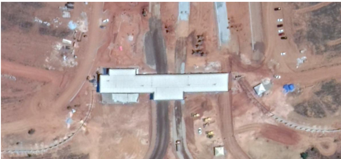
Figura 17 - Localização da portaria do Condomínio Genebra Fonte: Autor (2018)
