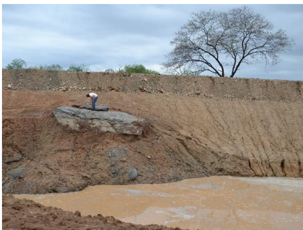
Figura 3-45. Barragem localizada na propriedade do Sr. Nivaldo.
