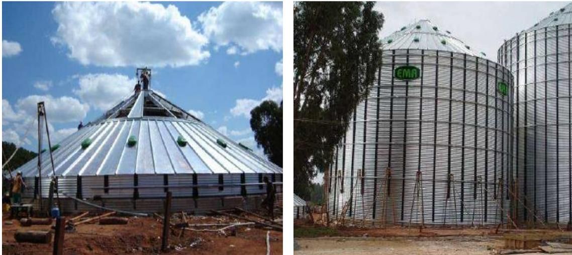
**Figura 2.2.** Principais componentes de um silo metálico. a) Telhado b) Chapas e Montantes (Scalabrin, 2008)
