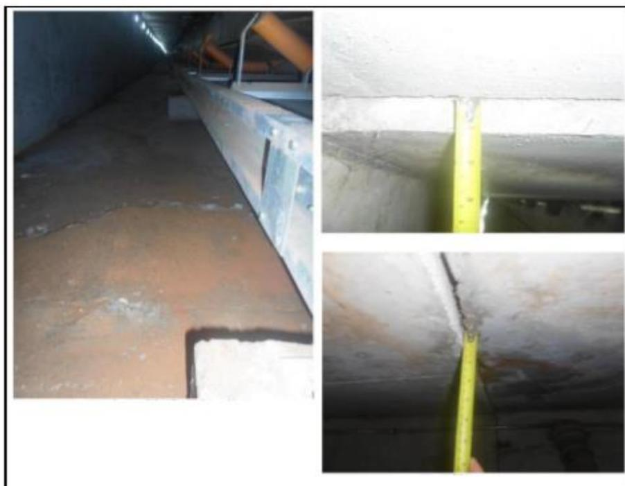
**Figura 3.7.** Trincas e deslocamentos gerados após o carregamento dos silos (EPF Geotecnia, 2017).
