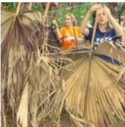
Figura 41 – Trabalho manual de construção da cabana (arquivo do projeto)
