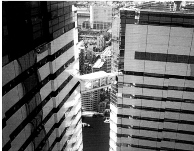
Figura 2.16 – Exemplo de sistema de acoplamento. Escritório Triton Square, Tokyo. (Christenson et al. , 2007).
