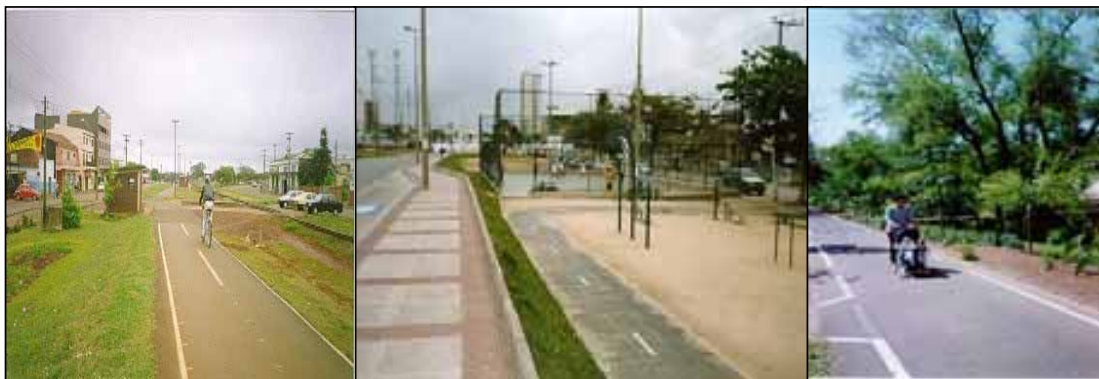
Figura 3.14 – Aplicação de Pavimentos Betuminosos (GEIPOT, 2001)
