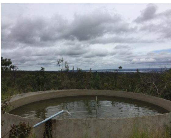
Figura 4. Tanque de entrada.
