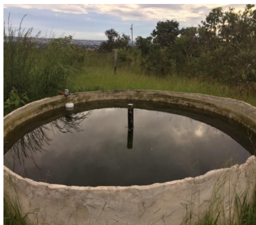
Figura 13. Tanque recalque da entrada.
