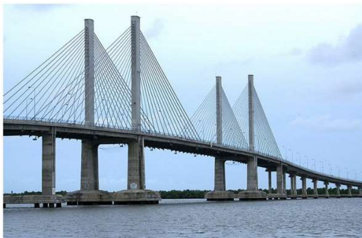
Figura A.30: Ponte Construtor João Alves, Sergipe Fonte: (MAZARIM, 2011)
