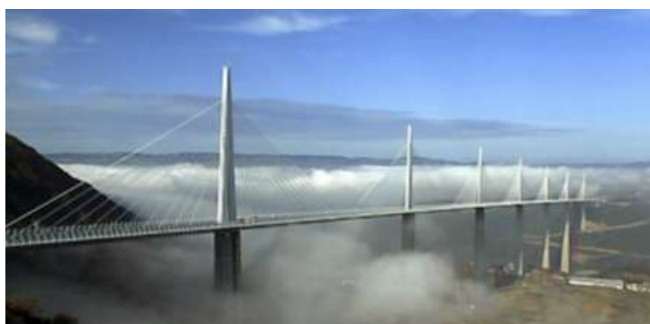
Figura A.18: Viaduto Millau, França Fonte: (OMEGA CENTRE, 2010)
