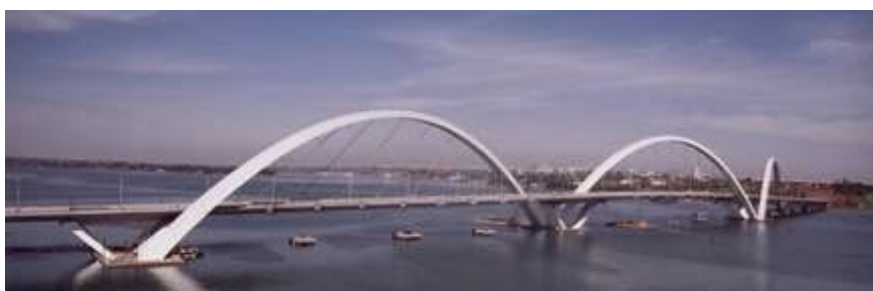
Figura A.27: Ponte Juscelino Kubitschek, Distrito Federal
