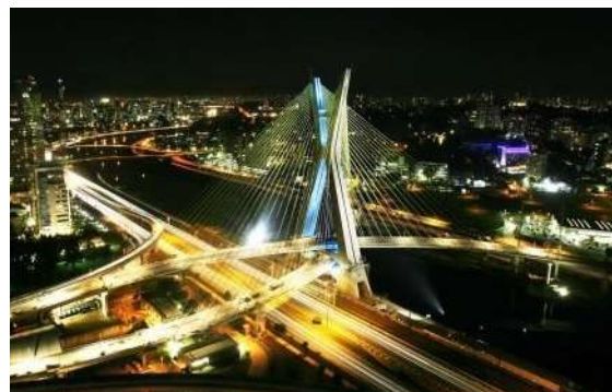
Figura A.32: Ponte Octávio Frias de Oliveira, São Paulo Fonte: http://www.isiengenharia.com.br/ , Acesso: 14/07/2014
