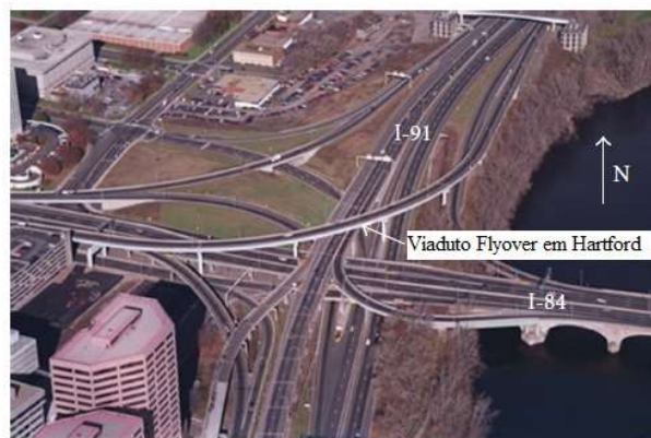
Figura 2.10: Viaduto Hartford Connecticut, Estados Unidos Fonte: (Scianna et al., 2012)
