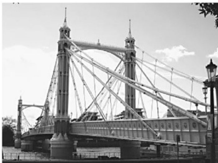
Figura A.10: Ponte Albert sobre o rio Tamisa, Londres Fonte: (GIMSING e GEORGAKIS, 2011)
