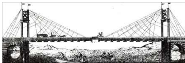
Figura A.8: Ponte Nienburg Saale, Alemanha
