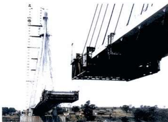
Figura A.24: Ponte Alencastro, Minas Gerais e Mato Grosso do Sul
