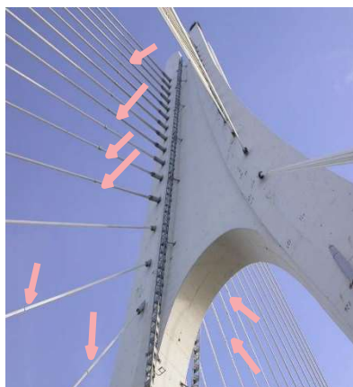
Figura 3.5: Detalhes das cintas metálicas envolvendo feixes de cordões autoprotégidos Fonte: (CAETANO, MAGALHÃES e CUNHA, 2007)
