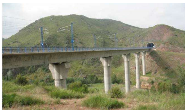
Figura 2.19: Ponte Jalon, Espanha Fonte: (XIA e ROECK, 2014)
