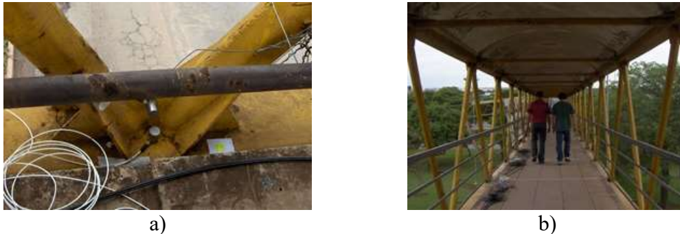
a) b) Figura 2.12: Passarela EPIA Brasília, Distrito Federal a) Detalhe dos acelerômetros; b) Pedestres caminhando. Fonte: (BRASILIANO et al., 2008)
