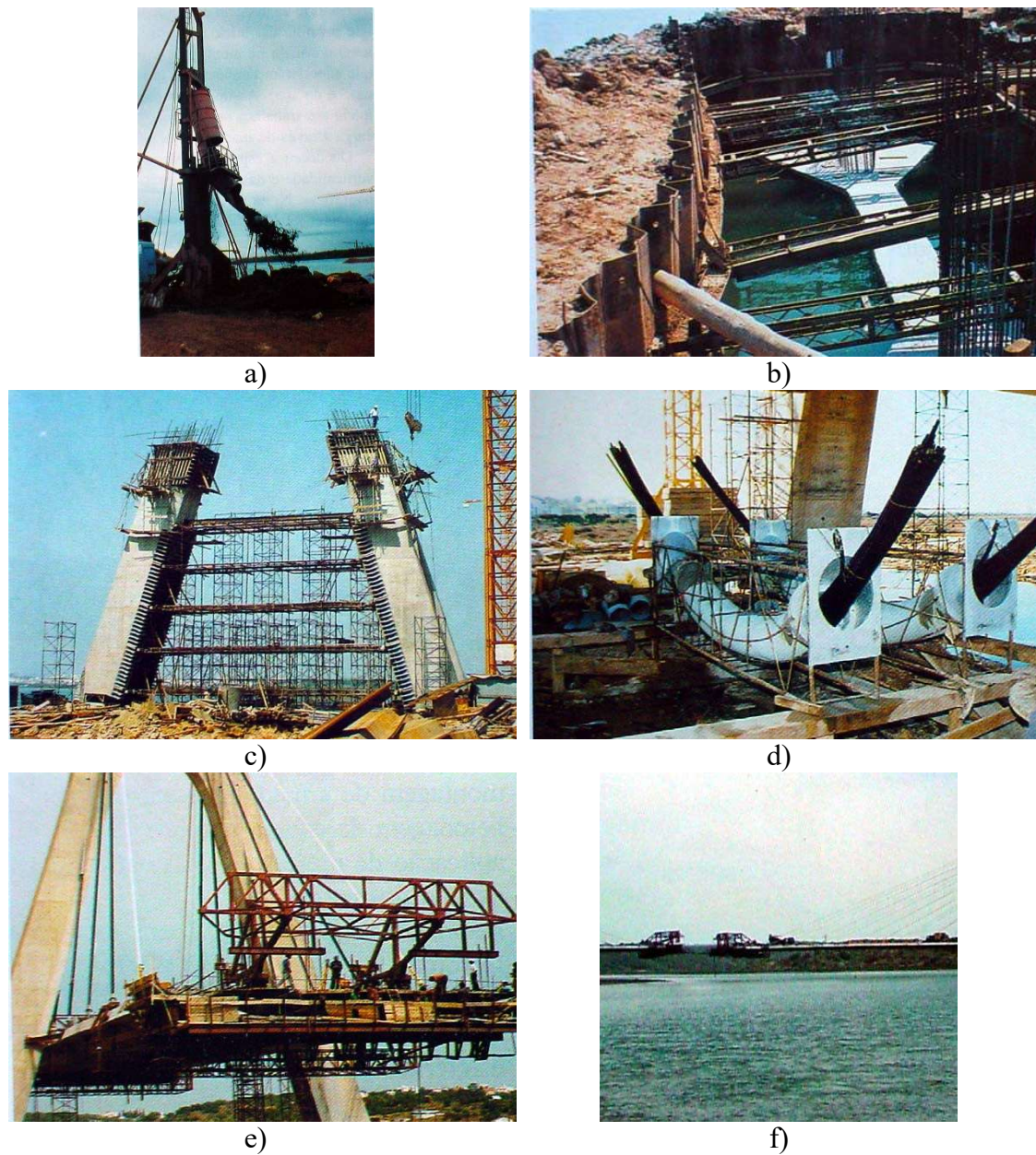
Figura 3.2: Detalhes da construção da Ponte sobre o Rio Arade a) Execução das fundações; b) Ensecadeiras para construção dos blocos das estacas; c) Contraventamento das torres; d) Selas pré-montadas; e) Construção do tabuleiro; f) Desnível entre os dois lados antes da concretagem da aduela de fechamento central Fonte: (FERNANDES e SANTOS, 1993)
