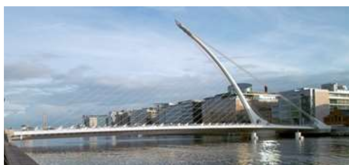
Figura A.43: Ponte sistema em harpa, Samuel Beckett Bridge Dublin, Irlanda. Fonte: http://en.wikipedia.org/ Acesso: 06/06/2014
