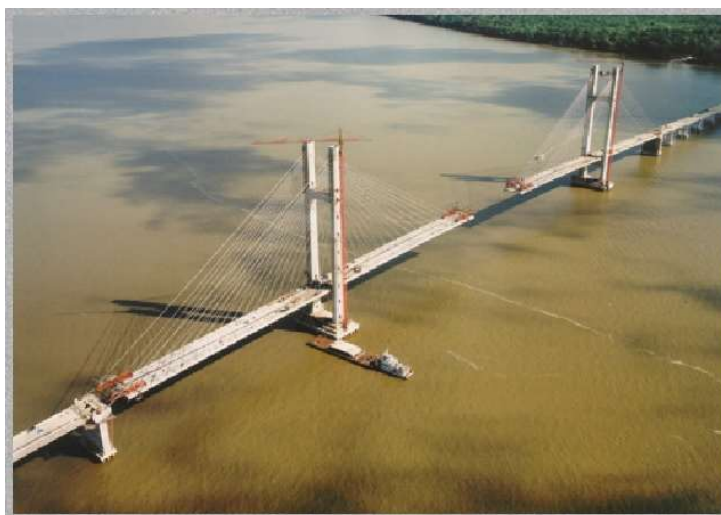
Figura A.26: Ponte sobre o rio Guamá, Pará
