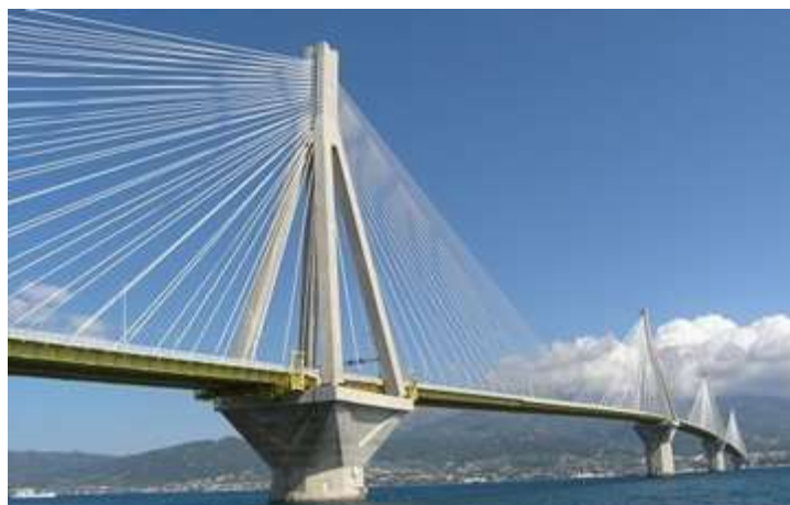
Figura A.42: Ponte sistema intermediário, ponte rio Antírio Patras, Grécia. Fonte: http://en.gefyra.gr/ Acesso: 06/06/2014
