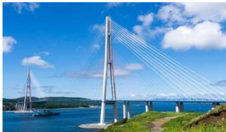
Figura A.22: Ponte para a ilha Russky Vladivostok, Rússia Fonte: http://rusbridge.net/ Acesso: 28/08/2014
