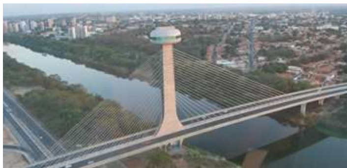
Figura A.35: Ponte Isidoro França, Piauí Fonte: (MAZARIM, 2011)
