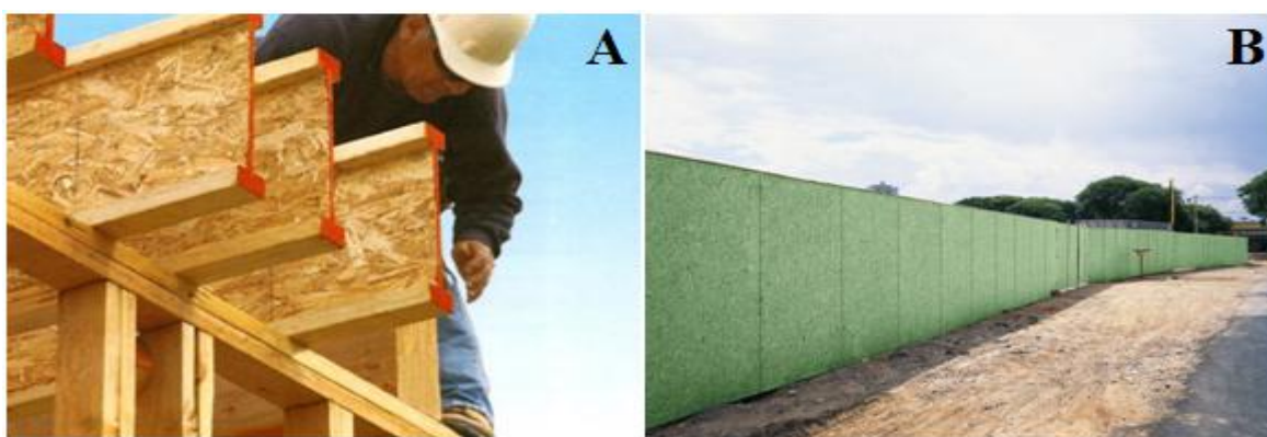
Figura 1. Painel OSB utilizado como viga em I (A), e como tapume para delimitar canteiro de obra (B) Fonte: LP BRASIL (2017).
