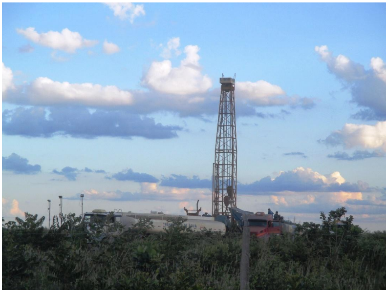
Figura 80 - Perfuração de um novo poço artesiano no território do Revis (janeiro de 2017)
