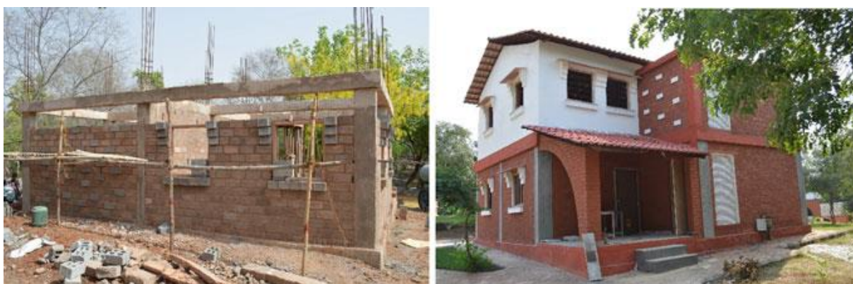
Figura 3-22: Edificação residencial construída apenas com produtos fabricados a partir do cimento LC 3 . (MAITY, BISHNOI e KUMAR, 2015).
