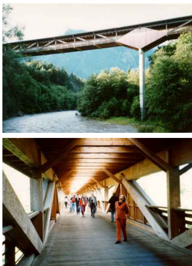
Figura 80 – Ponte estruturada em treliça plana de madeira com vão central de 54m e comprimento total de 108m, nos Alpes suíços. Fonte: MELLO (1998).
