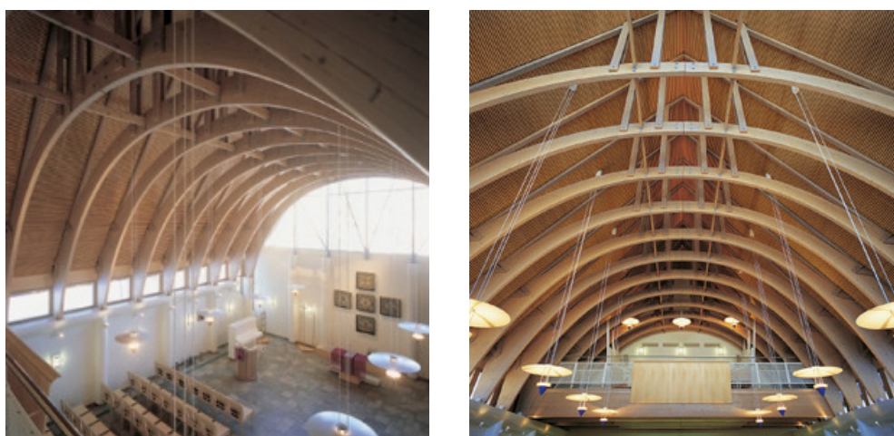
Figura 86 – Capela com arcos em madeira laminada colada, na Finlândia. Fonte: FINNFOREST (2006).
