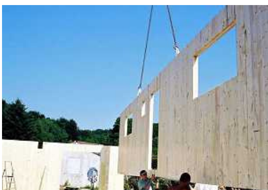
Figura 70 – Montagem de painéis nas obras. Fonte: IDEESMAISON (2007).
