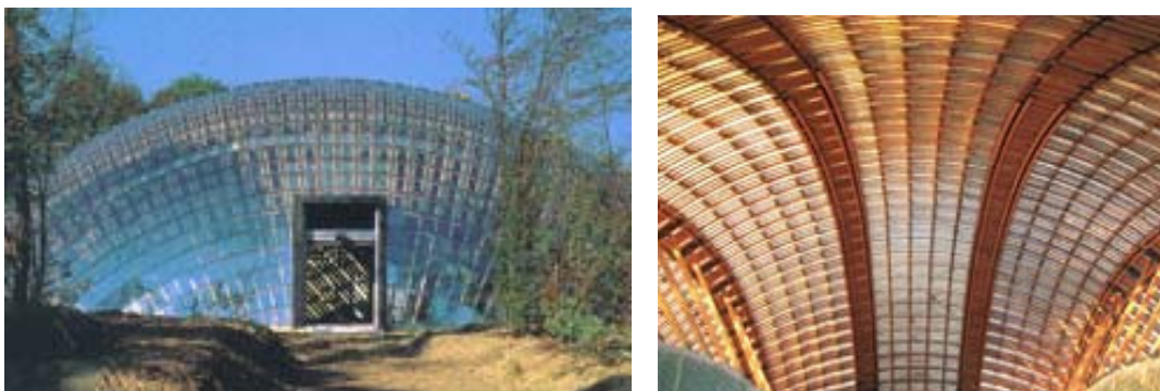
Figura 97 – Casca em forma ovóide com estrutura em arcos compostos fixados em radier de concreto armado, na Bélgica. Fonte: CRIT (2005).
