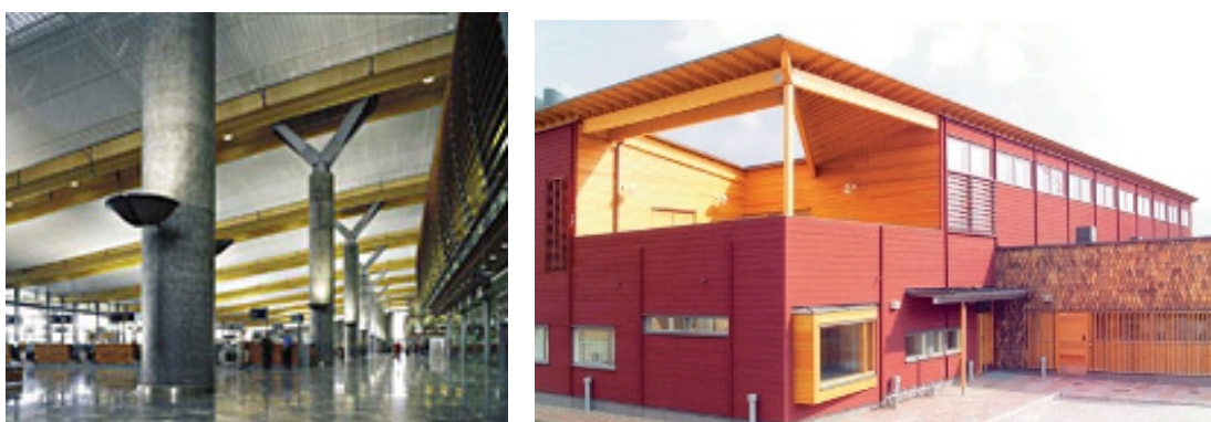
Figura 74 – Vigas contínuas em MLC no novo aeroporto de Oslo, Noruega, e em escola na Finlândia. Fonte: FINNFOREST (2007).
