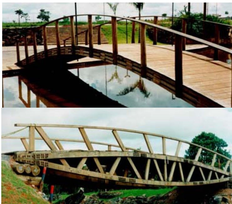
Figura 87 – Pontes em arco (acima) e arco treliçado (abaixo) executadas com peças de madeira maciça, em Goiânia (GO) e Brasília (DF). Fonte: MELLO (1998).
