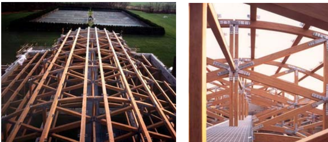
Figura 81 – Exemplo de tesoura com três articulações em edifício agrícola, com passarela fixada na articulação central. Fonte: UNALAM (2006).
