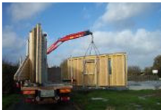
Figura 70 – Montagem de painéis nas obras. Fonte: IDEESMAISON (2007).
