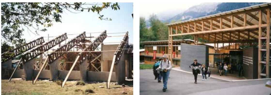
Figura 79 – Treliças planas de madeira em edificação do INCRA no Pará, e com diagonais metálicas no museu de Ballenberg, Suíça. Fonte: MELLO (1998-2002).
