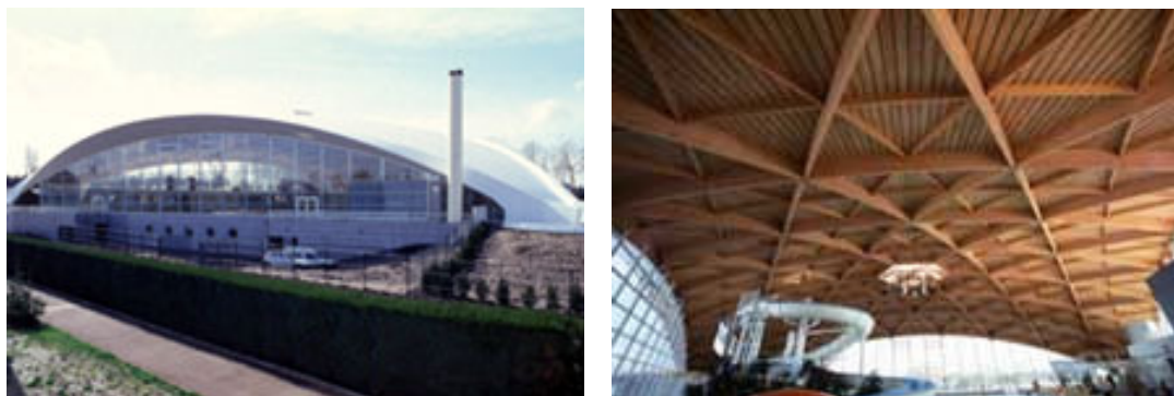
Figura 96 – Casca de cobertura de uma piscina, que se apóia sobre três pontos no solo, com vãos de 58m entre os pontos, na França. Fonte: CRIT (2005).
