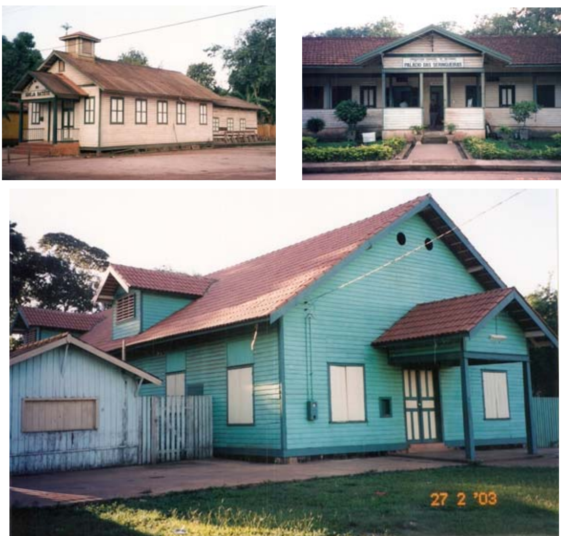
Figura 107 – Igreja, prefeitura e escola da cidade de madeira de Belterra (antiga Fordlândia), construída às margens do rio Tapajós, no oeste do Estado do Pará, pelo magnata Henry Ford, para instalação de uma base de exploração de borracha. Fonte: MELLO (2003).
