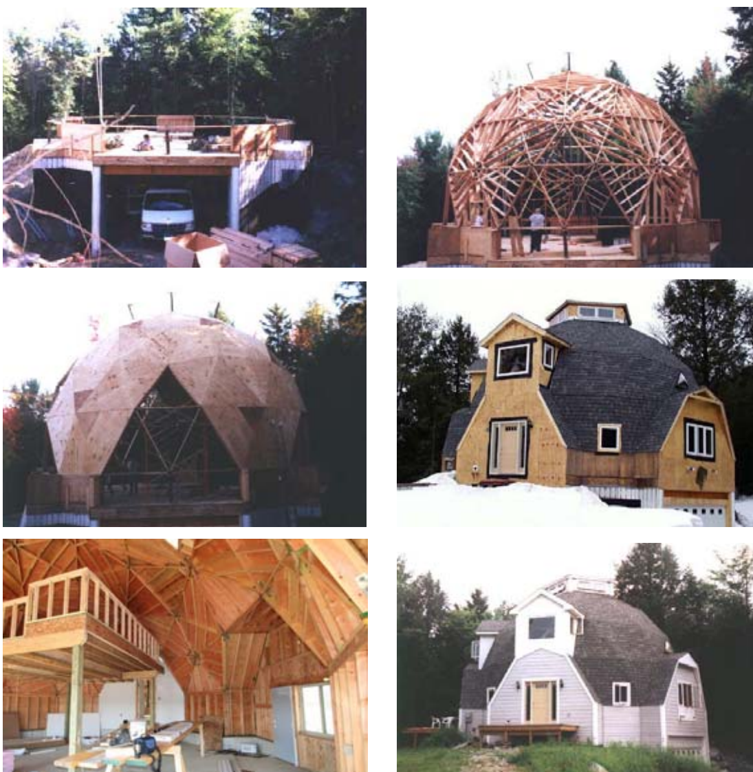
Figura 99 – Seqüência de fabricação de casa com cúpula geodésica nos EUA, com execução de embasamento em concreto armado, armação em montantes de madeira, enrijecimento com chapas de compensado, execução de complementos, com vista interna mostrando mezanino, e a obra acabada. Fonte: HORTONDOME (2004).
