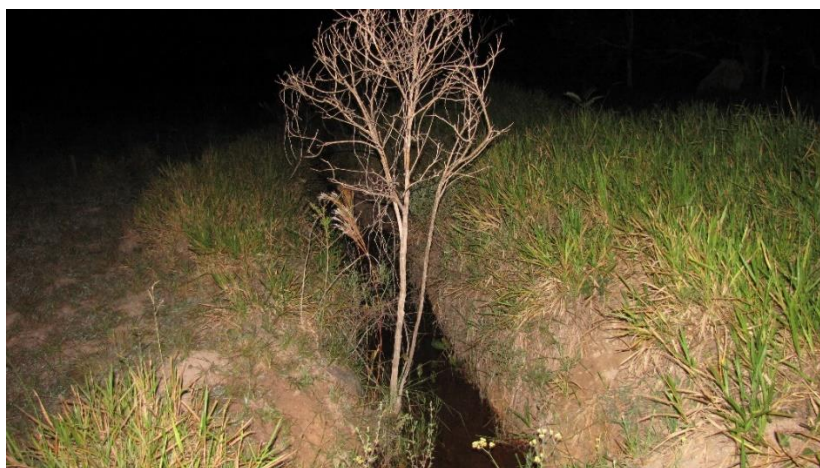
Imagem 6: Calha de drenagem
