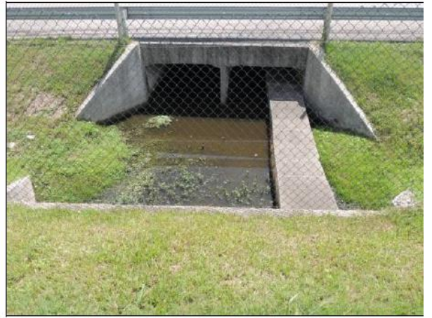
Passagem de fauna inferior adaptado em bueiro celular duplo, km 57,500, lote 2.
