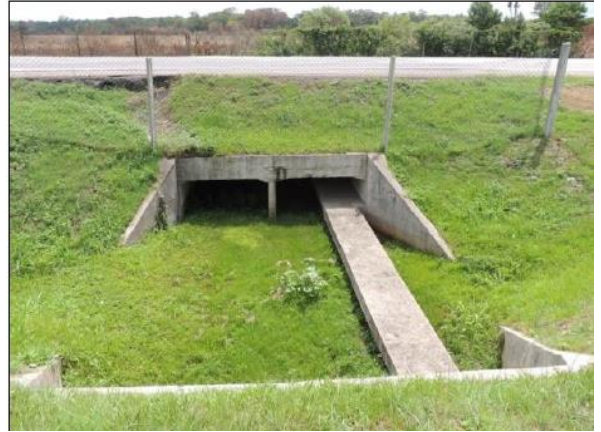
Passagem de fauna inferior adaptado em bueiro celular duplo, km 41,497, lote 2.
