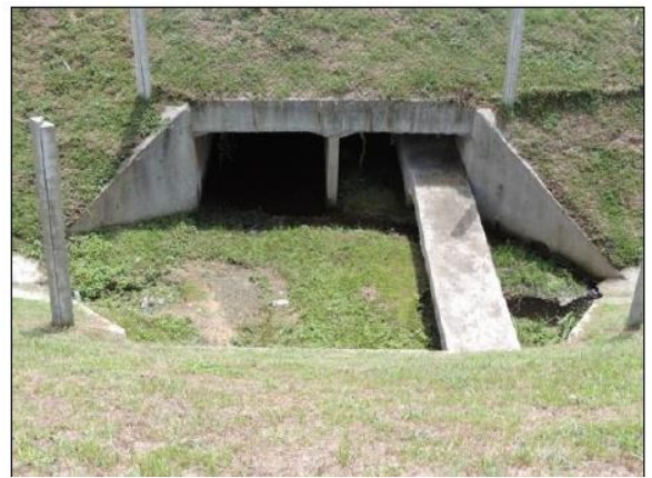
Passagem de fauna inferior adaptado em bueiro celular duplo, km 49,255, lote 2.
