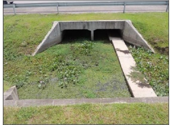
Passagem de fauna inferior adaptado em bueiro celular duplo, km 49,255, lote 2.
