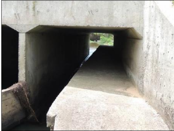
Passagem de fauna inferior adaptado em bueiro celular duplo, km 36,420, lote 2.
