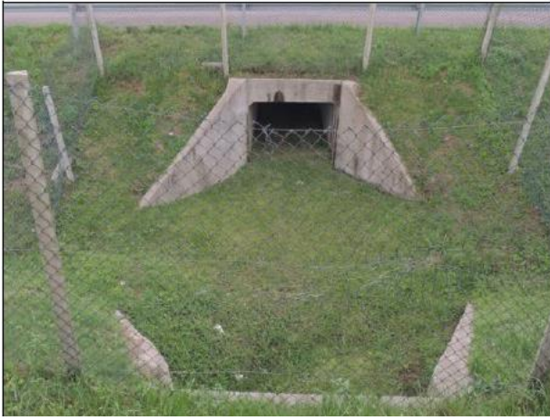
Passagem de fauna inferior em bueiro celular simples, km 38,640, lote 2.
