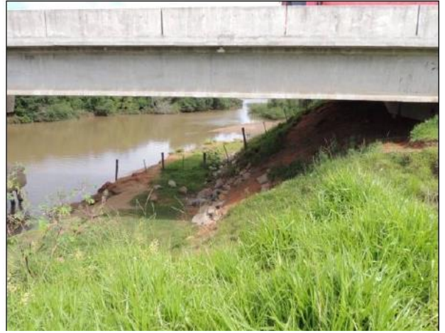
Passagem de fauna na Ponte sobre o Arroio Pelotas, km 512,000, lote 1.
