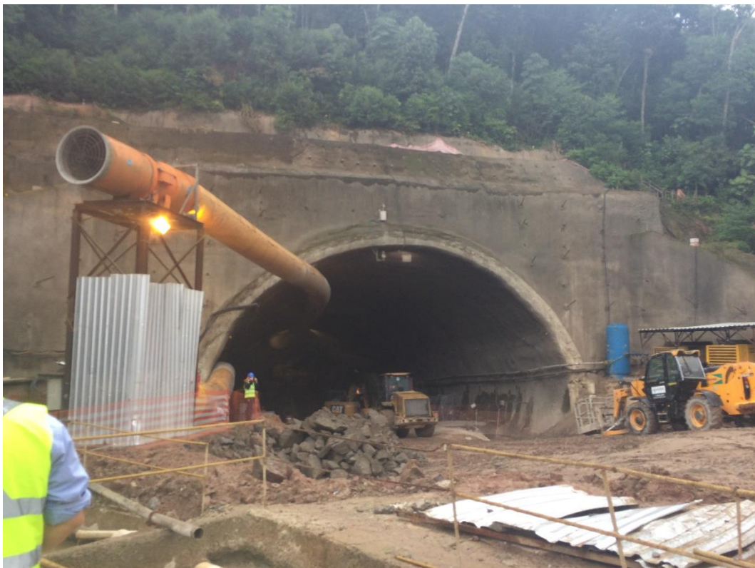
Figura 2.9 – Emboque do túnel 4 do projeto de duplicação da autopista Régis Bittencourt em abril de 2017, em construção (Fonte: próprio autor)
