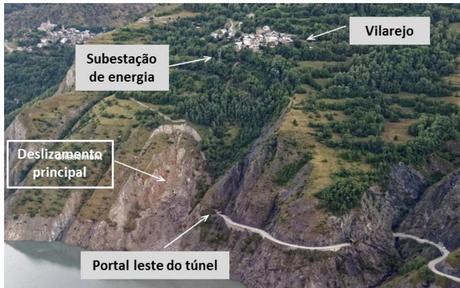
Figura 2.5 – Situação da região da ruptura - Túnel Chambon (modificado de Deffayet, 2016)
