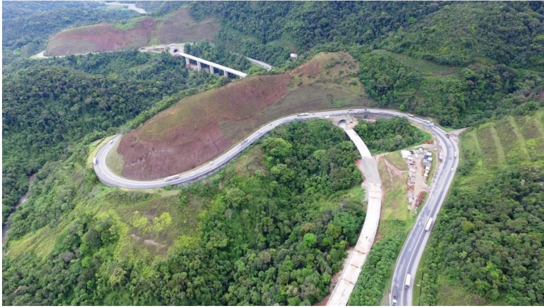
Figura 2.8 – Vista aérea de trecho da autopista Régis Bittencourt (Arteris, 2015)
