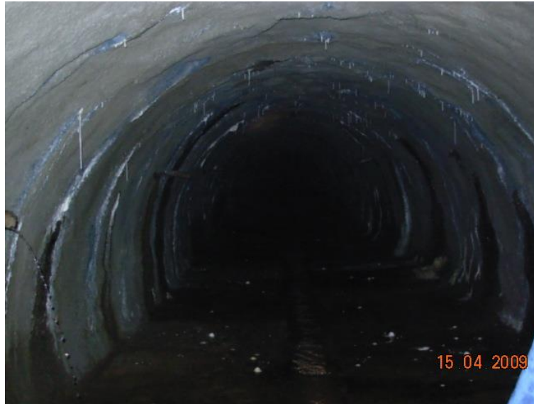
Figura 4.2 – Foto interna do túnel de drenagem, podendo ser observados o formato da seção transversal do túnel e a água drenada por meio de drenos radiais (Figueiredo Ferraz, 2009)
