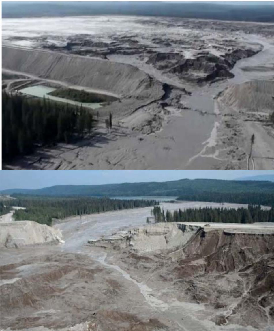
Figura 2.12: barragem de rejeitos Mount Polley após ruptura e o fluxo pelo vale do lago (CBC, 2014)
