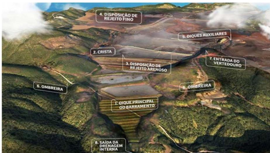
Figura 2.4: Estruturas de uma barragem de rejeitos (SAMARCO, 2016)
