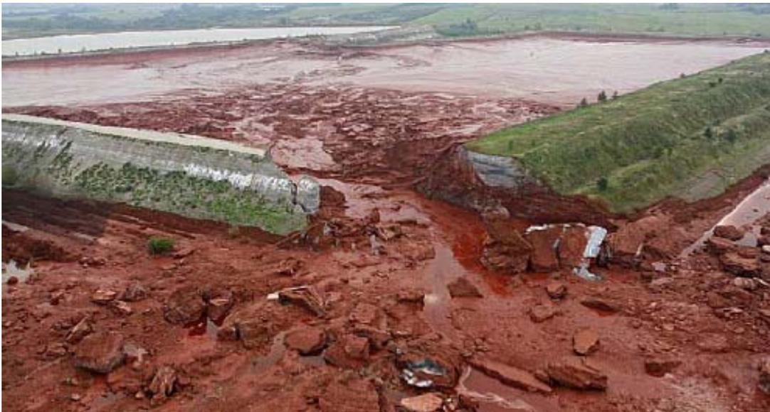
Figura 2.10: Barragem de rejeitos da Usina de alumina em Ajka, Hungria (USSD, 2013)
