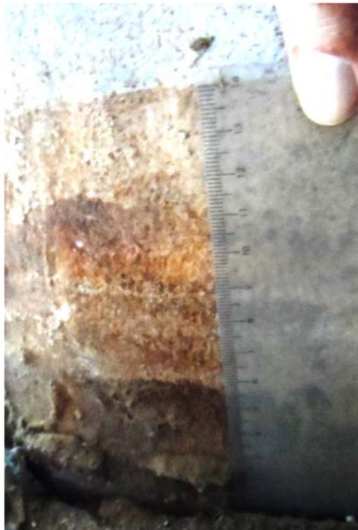
Figura 4.13: Coleta de alturas de inundação e de material retido dentro de edificação
