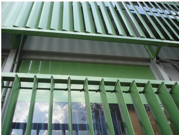
Figura 5-66- Detalhe do perfil do brise-soleil vertical e a angulação de abertura
