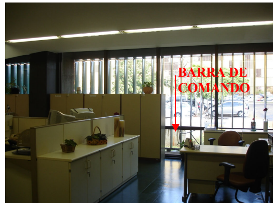
Figura 5-55- Armários impedindo o acesso à barra de comando
