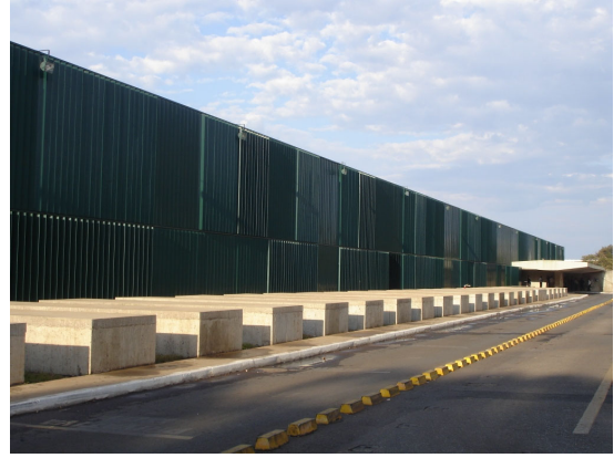
Figura 5-37- Fachada sul e a predominância dos brises
