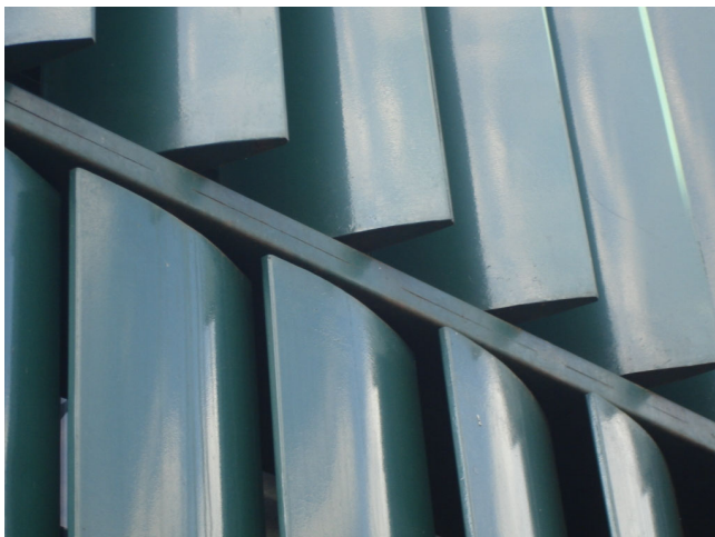
Figura 5-38- Detalhe do perfil do brise-soleil e a angulação de abertura
