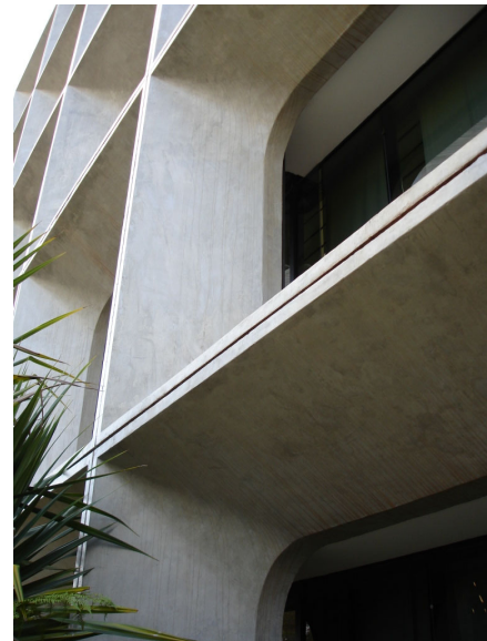
Figura 5-111- Detalhe do brise-soleil misto
