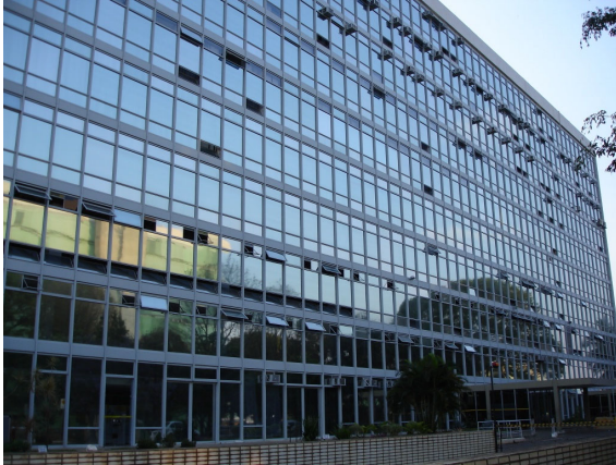
Figura 5-64- Fachada leste (108°): película espelhada
