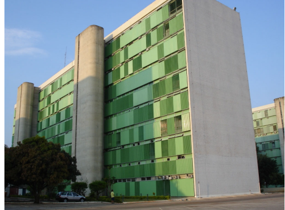
Figura 5-65- Fachada oeste (288°): brise-soleil vertical
