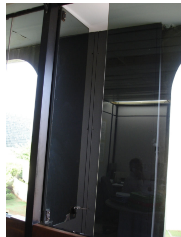
Figura 5-108- Detalhe da janela
