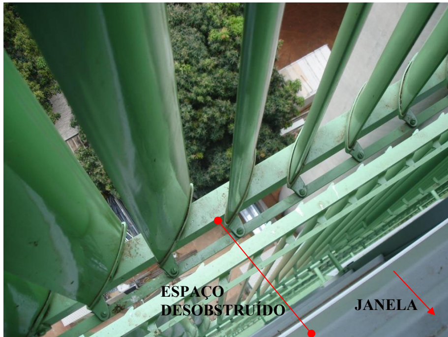
Figura 5-96- Vista através da janela do quinto pavimento para o nível da rua: desobstrução entre os brises e a superfície envidraçada
