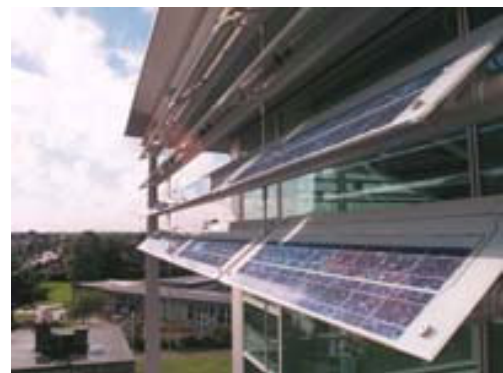
b) Brise fotovoltaico
