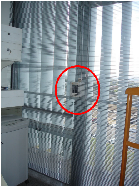
Figura 5-8- Caixa de comando fixa na estrutura metálica
