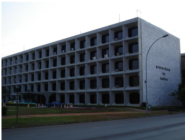
Figura 5-107- Fachada leste (108°): brise misto e vidro fumê
