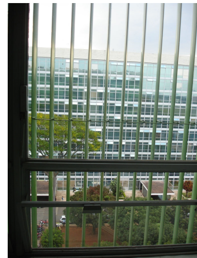
Figura 5-69- Acesso aos brises pela janela
