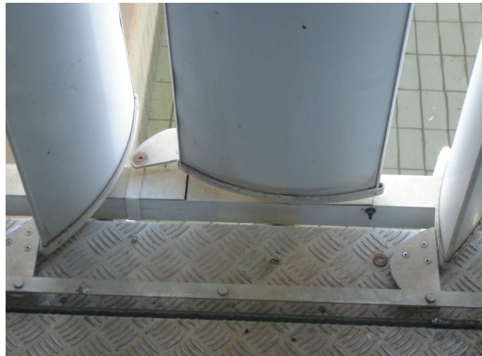
Figura 5-22- Lâmina quebrada
