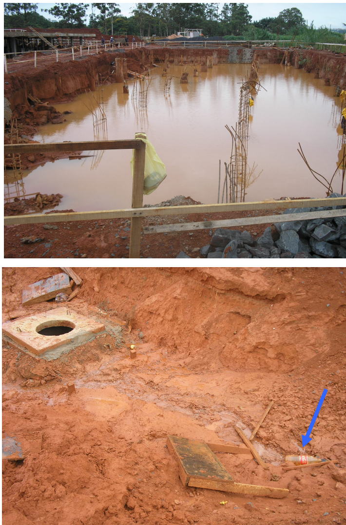
Figura 3.10 – Fotos do local da obra com detalhe do nível d'água aflorante - Projeto Ilhas do Lago.
