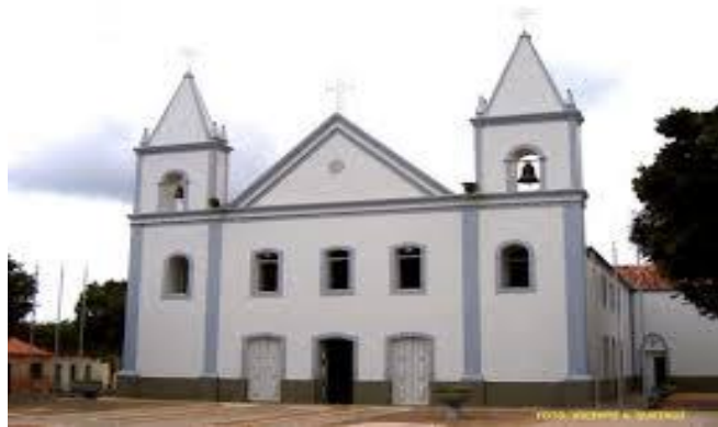
Figura 11 -Fachada da Igreja da Matriz de São Raimundo Nonato
