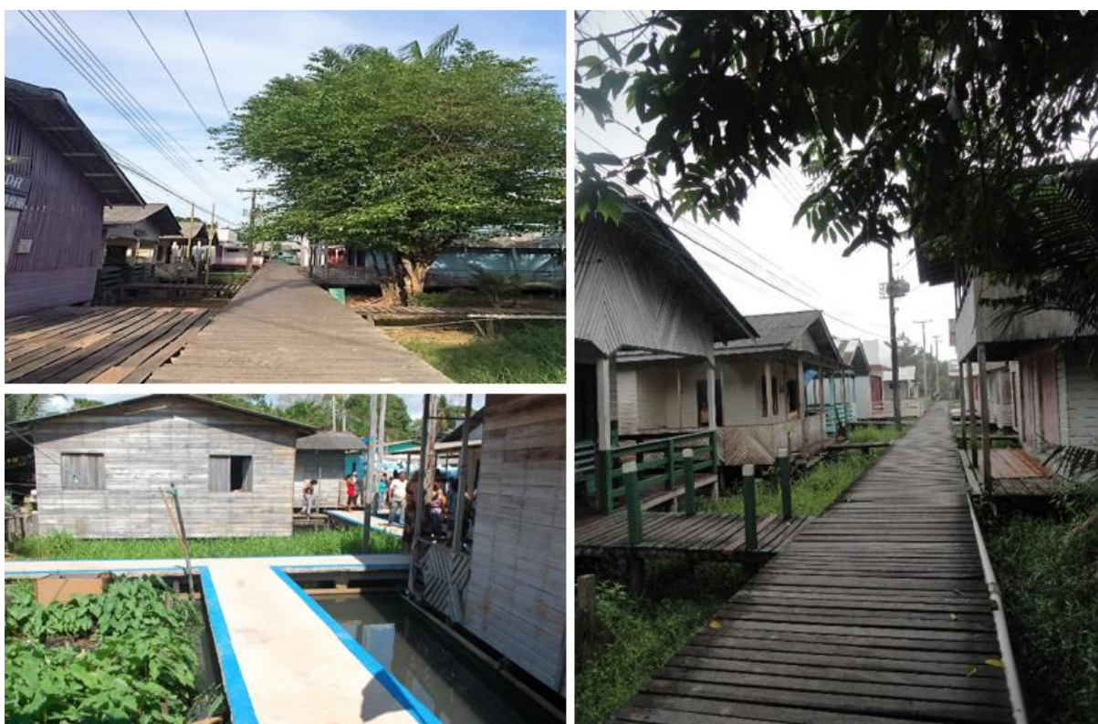
Figura 4. Passarelas de madeira, principal via pública das Vilas.
