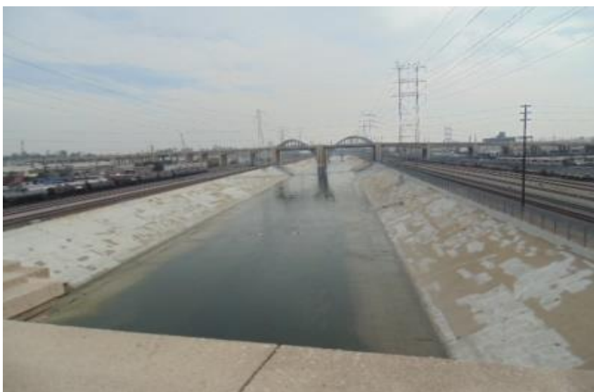
Figura 45: Los Angeles River, Downtown . Los Angeles/CA. Fonte: Acervo próprio, 2016.
