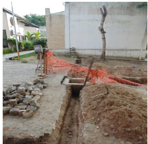
Figura 27: Substituição encanamento, Campus Sede/UFCG. Fonte: Acervo próprio, 2015.
