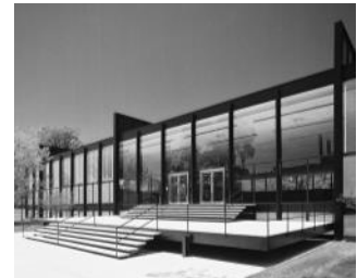
Figura 50 – Crown Hall (1950-56). Fonte: http://hagenstier.polychroma.de
