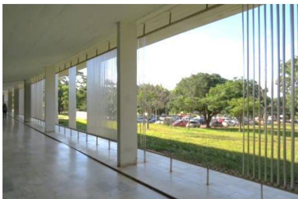
Figura 58 – Vista F: vista da fachada Leste. Foto da autora (jul/2015)
