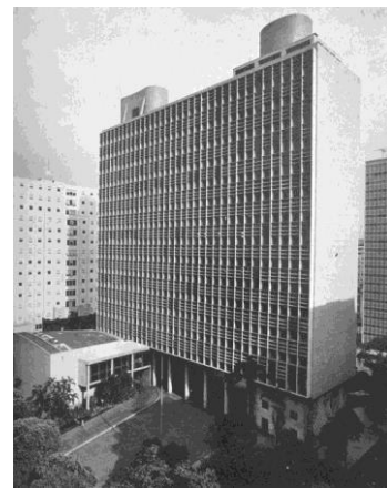
Figura 21 - Edifício do MEC (1936-1943). Fonte: http://lostonsite.com/2009/11/12/niemeyer/
