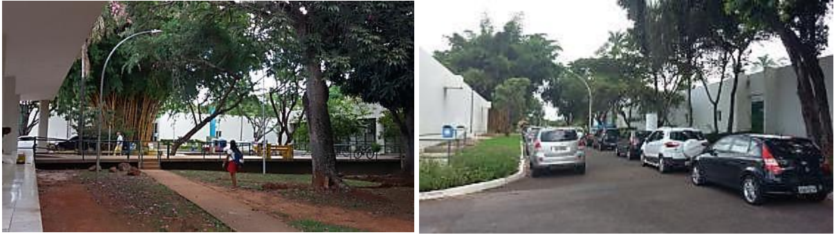
Figura 104 – Exemplos de barreiras: acesso Leste da ponte FE1-FE3 (esq.) e rua interna do conjunto, apinhada de carros estacionados (dir.). Fotos da autora (mar/2017).
