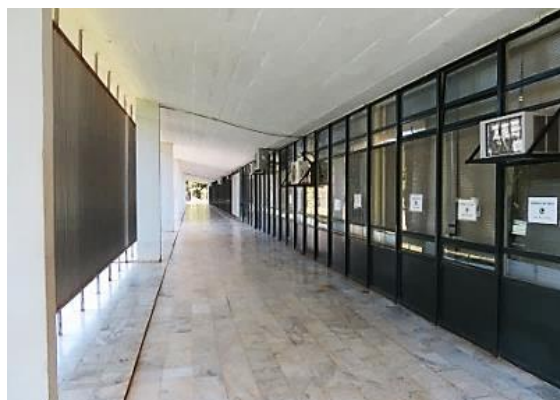
Figura 59 – Vista G: alpendre da fachada Leste. Foto da Autora (jul/2015)
