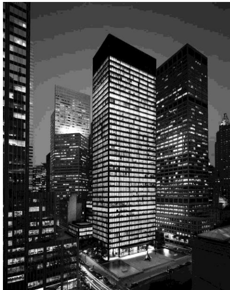
Figura 24 - Edifício Seagram em Nova Iorque (1958), de Mies Van der Rohe.
