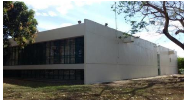
Figura 69 – Vista C: fachadas Sul (esq.) e Leste (dir.). Foto da autora (jul/2016)
