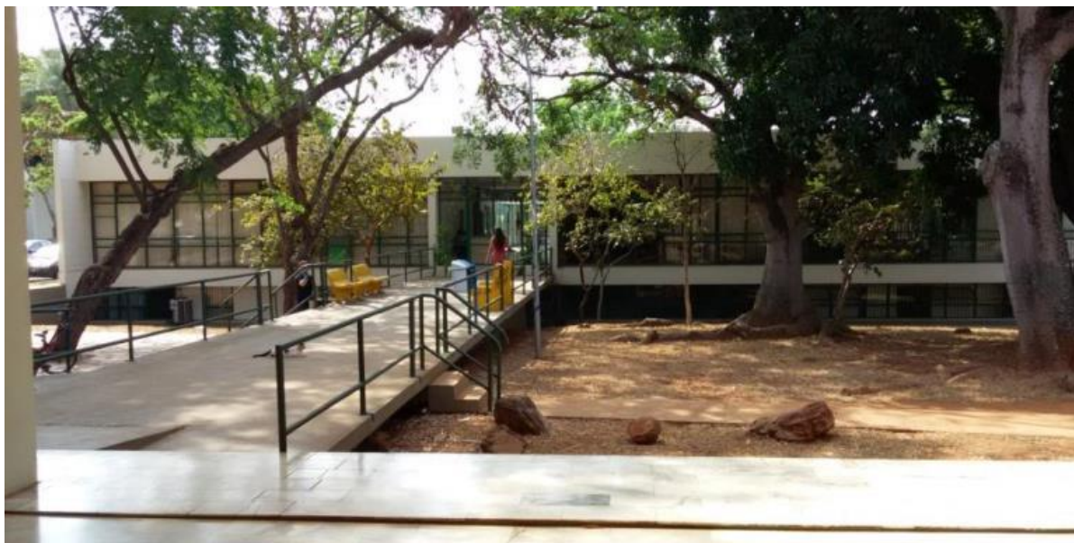
Figura 70 – Vista D: fachada Sul vista a partir da ponte que liga ao FE1; “Pracinha da FE”. Foto da autora (jul/2016)
