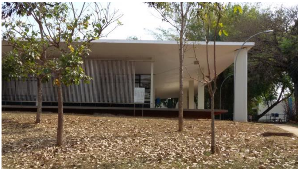
Figura 56 – Vista D: fachada Leste. Foto da autora (set/2015)
