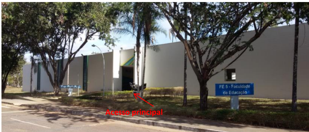
Figura 75 – Vista A: fachada Leste (principal). Foto da autora (2016)
