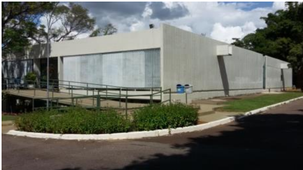
Figura 68 – Vista B: fachada Norte (esq.) e Oeste (dir.). Foto da autora (mar/2017)
