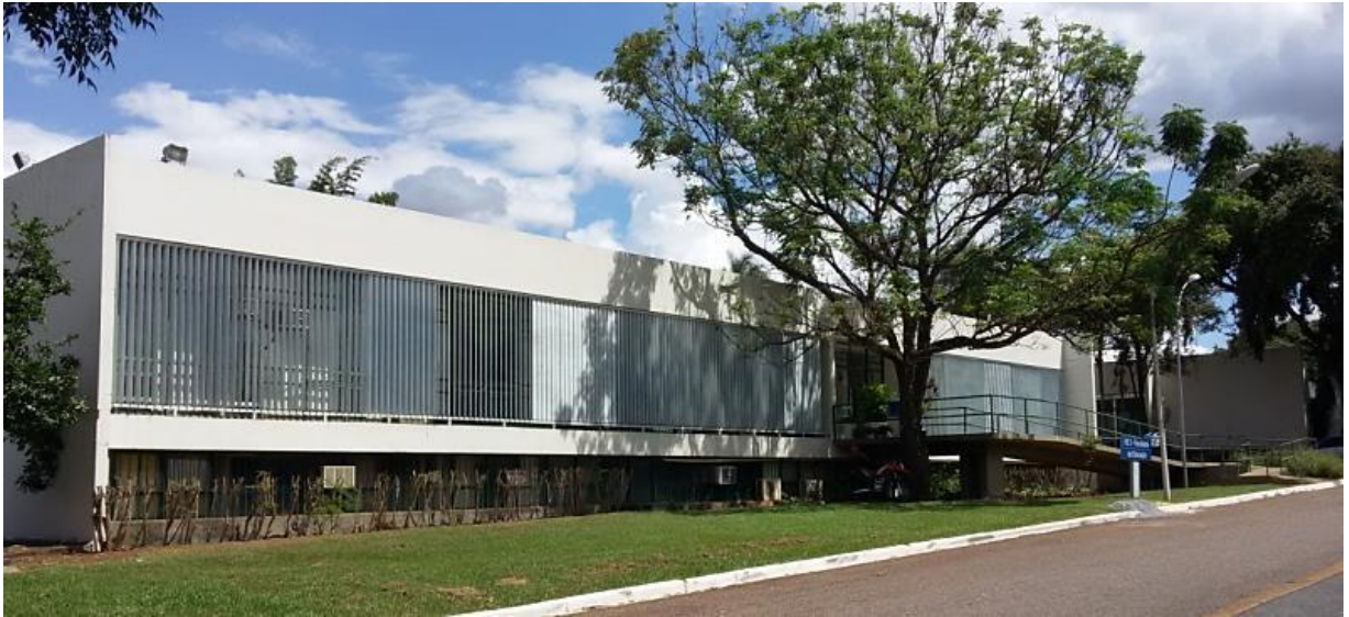
Figura 67 – Vista A: fachada Norte. Foto da autora (mar/2017)
