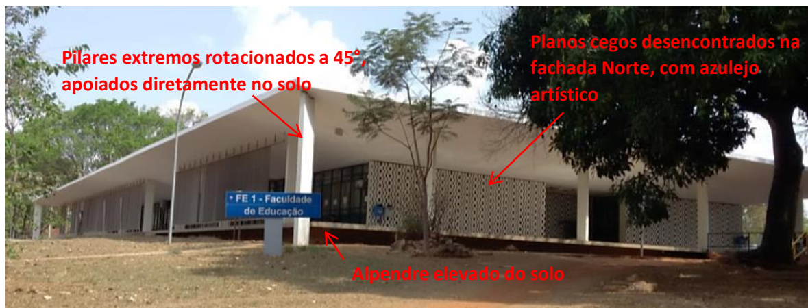
Figura 53- Vista A: fachadas Leste (esq.) e Norte (dir.). Foto da autora (set/2016)
