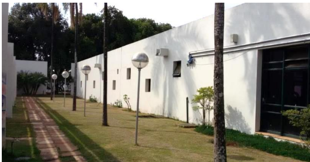
Figura 81 – Vista I: pátio interior, fachada Oeste. Foto da autora (jul/2016)
