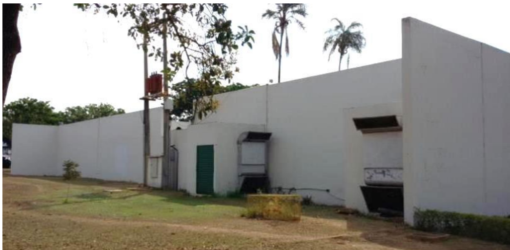
Figura 80 – Vista H: fachada Sul com casa de máquinas. Foto da autora (jul/2016)
