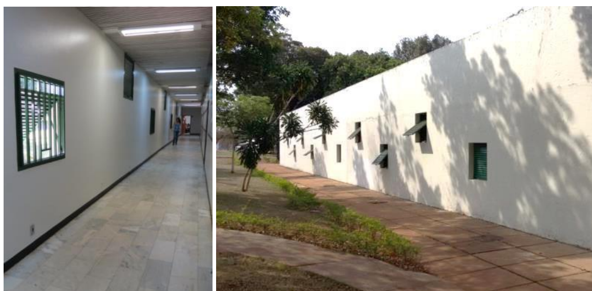
Figura 79 – Vista F (dir.) e vista G (esq.): fachada Oeste vista interna e vista externa. Fotos da autora (jul/2016)
