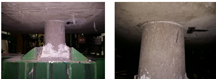
Figura 4.54 – Vista inferior depois da ruptura – Laje RSP-A01
