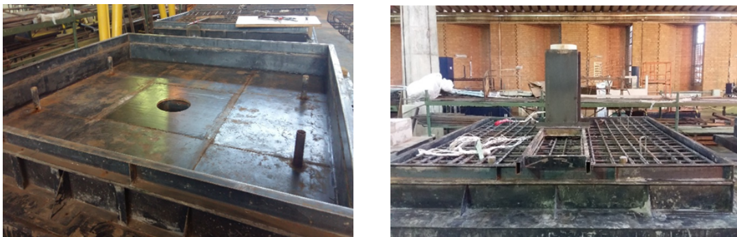
Figura 3.34 – Formas metálicas usadas na concretagem das lajes
