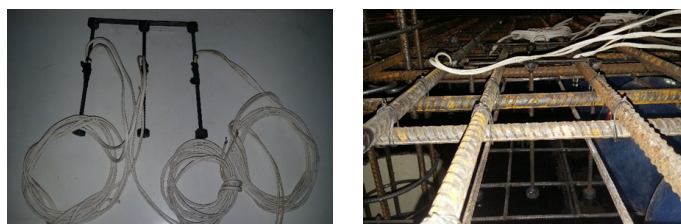
Figura 3.25 – Armaduras de cisalhamento instrumentadas
