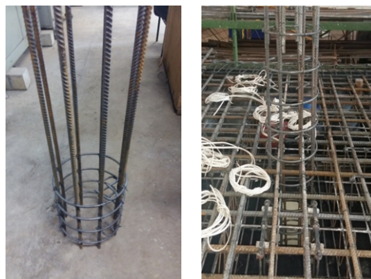
Figura 3.9 – Armadura dos pilares
