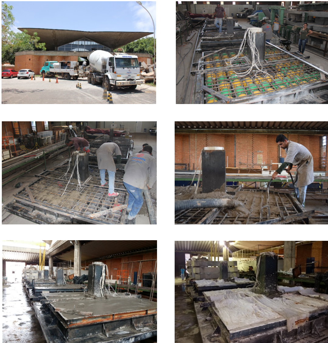
Figura 3.35 – Etapas da concretagem e cura das lajes
