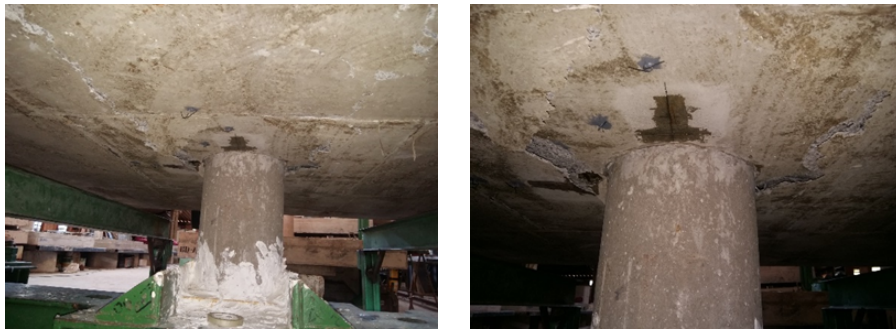
Figura 4.58 – Vista inferior depois da ruptura – Laje BD-A02
