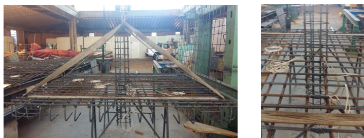
Figura 3.23 – Armadura de flexão
