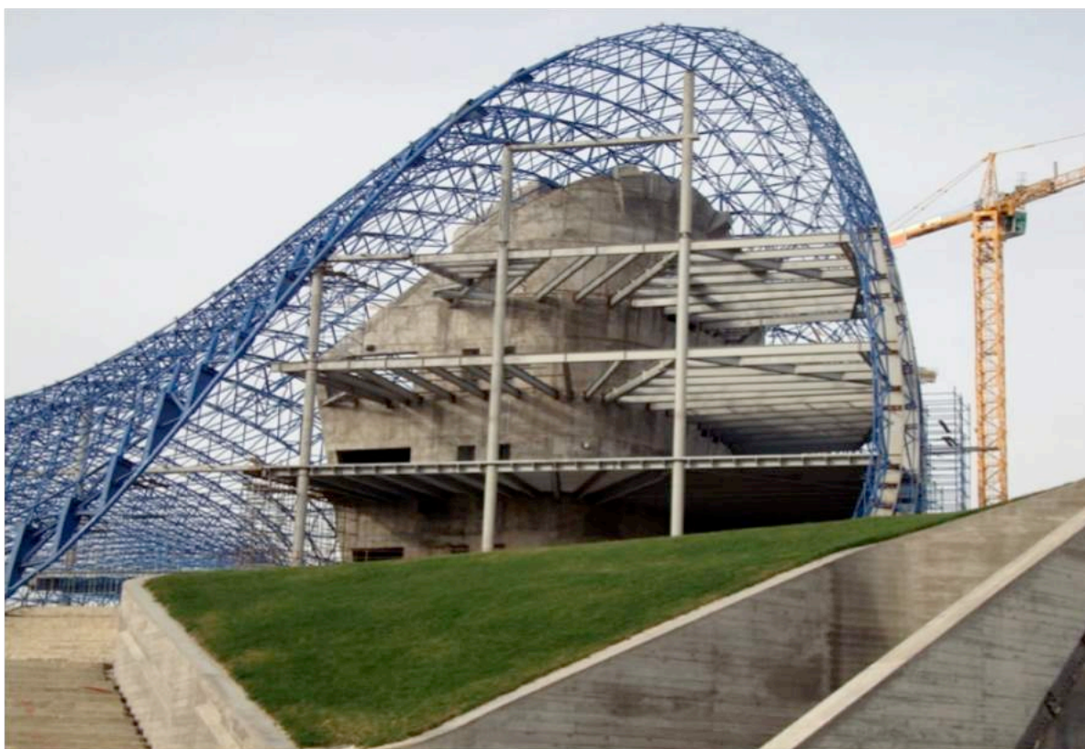
Figura 41: Estrutura do Heydar Aliyev Cultural Center Fonte: Arquiteta, 2016
