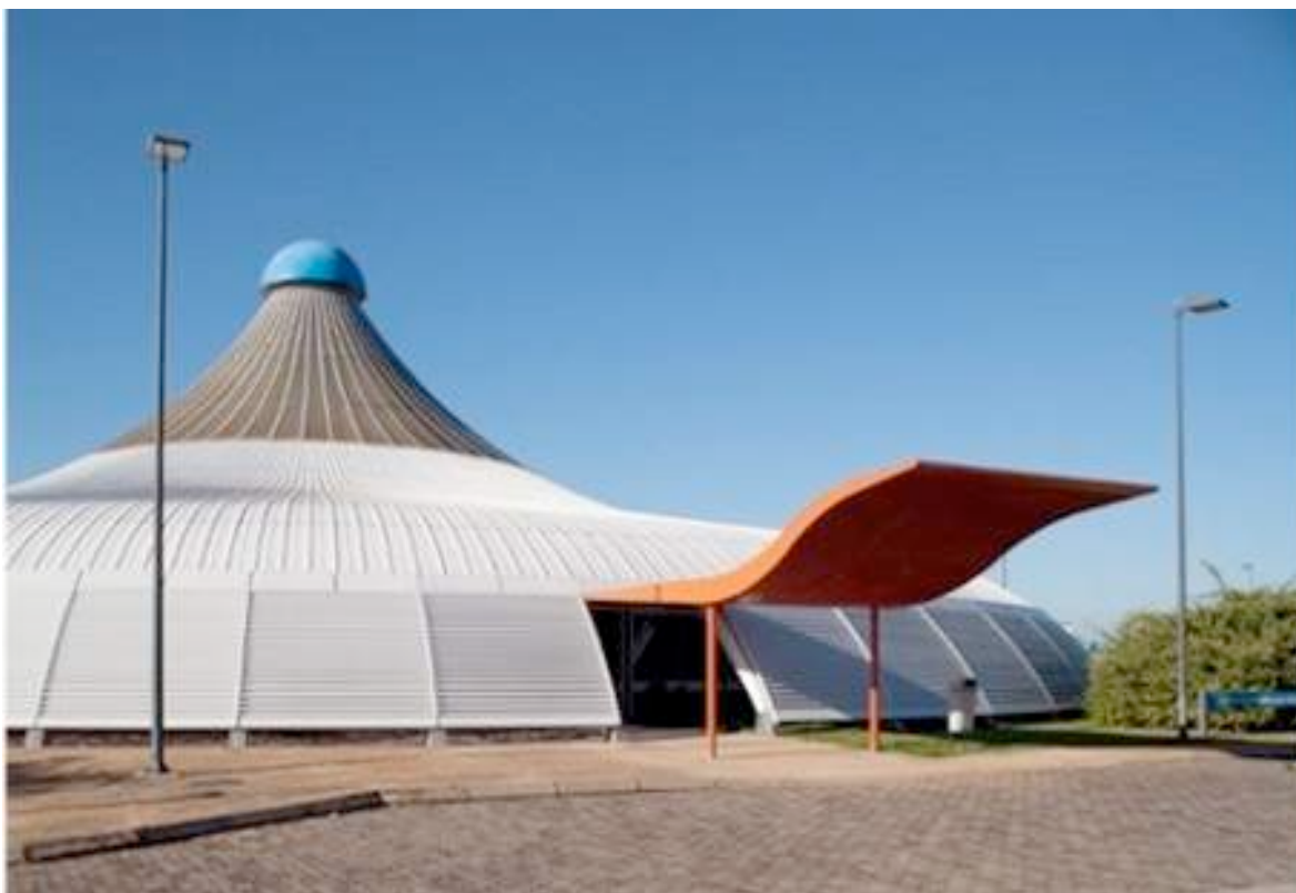
Figura 34: Memorial Darcy Ribeiro Fonte: Arquiteta, 2012
