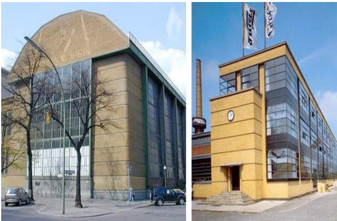
Figura 17: Fábrica de Turbinas AEG; Fábrica Fagus Fonte: Coisas da arquitetura, 2011
